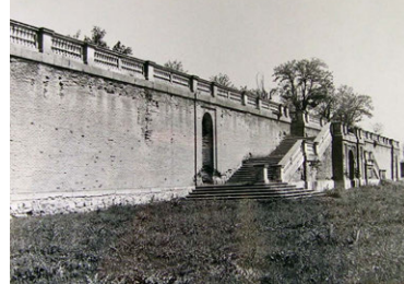
Muro de contención del jardín alto
