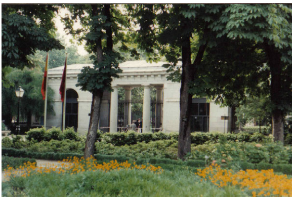
Vista de la Puerta de Murillo desde el interior
