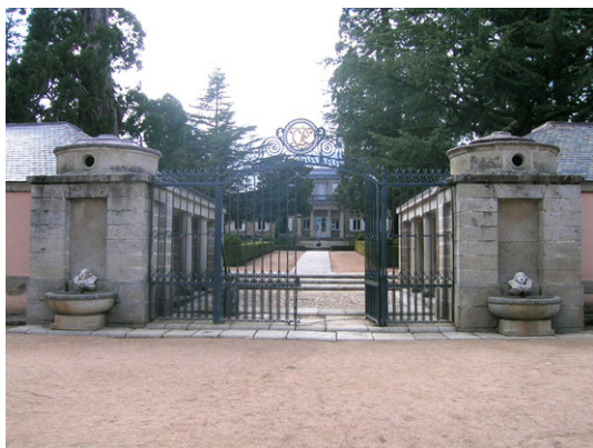
Vista del acceso
