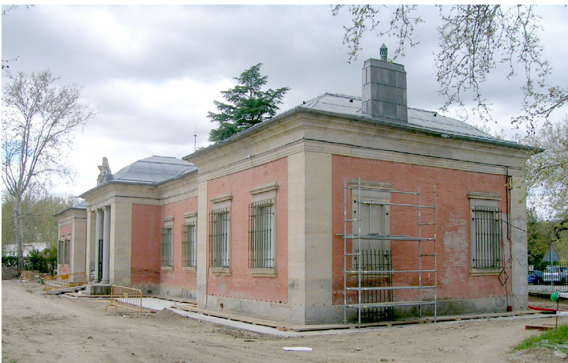
Vista de las fachadas principal y norte de la Casita
