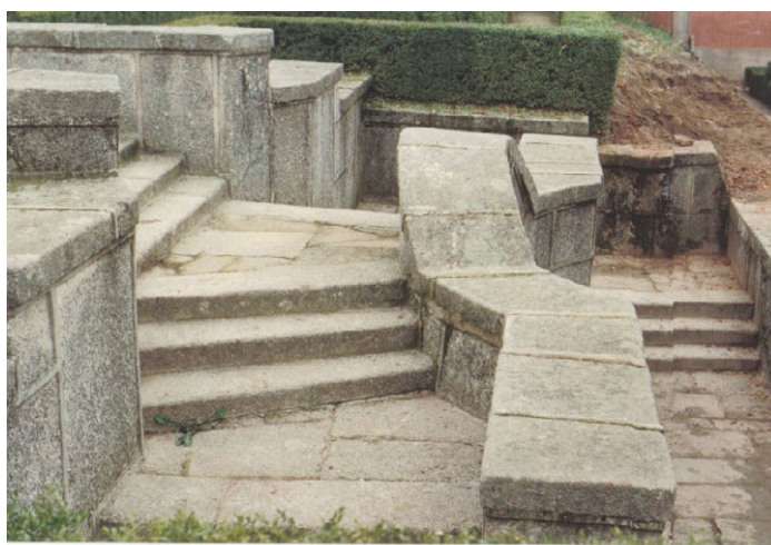
Vista de la escalera
