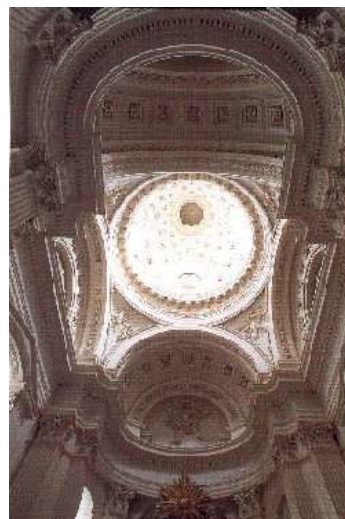
Vista del interior de la capilla
