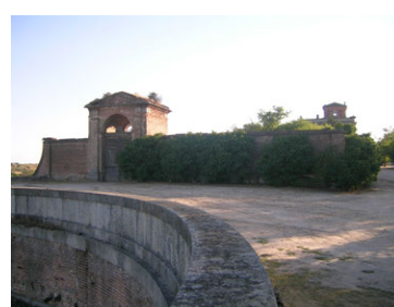
Vista de los accesos laterales
