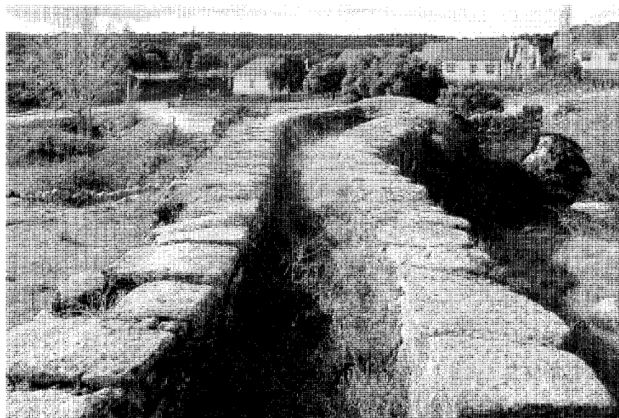
Molino frente a la urbanización Olivar de la Morena. Detalle del caz. Fot. Miguel Angel Vega Delgado.
