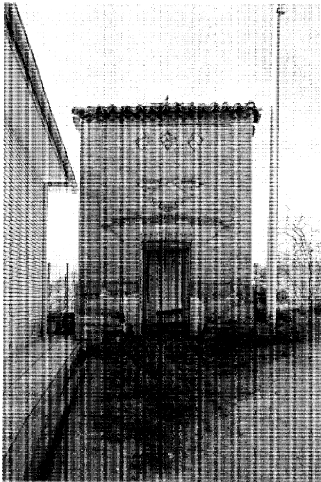
Transformador eléctrico construido a finales del siglo pasado. Fot. Actividades y Servicios Fotográficos, S.A.
