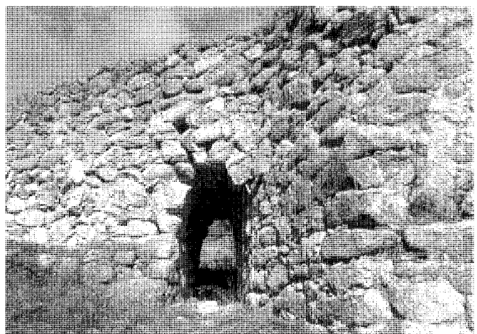
Hueco de paso a través del muro del caz. Fot. Miguel Angel Vega Delgado.
