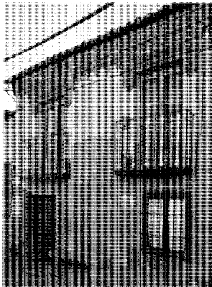
Vivienda en la calle Antonino Rofazza nº 4. Fot: Actividades y Servicios Fotográficos S.A.
