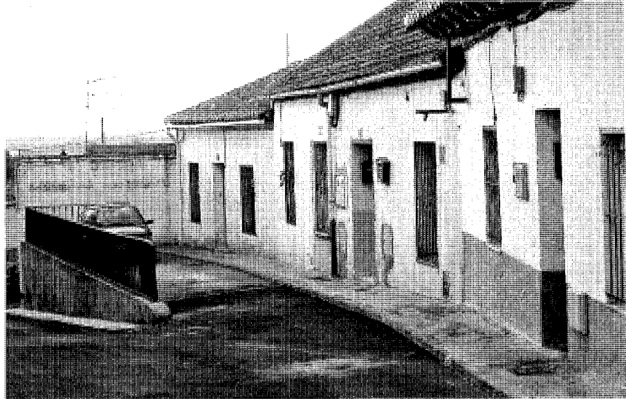
Agrupación de viviendas en la calle de las Huertas, antaño al borde del arroyo del Almuñadero. Foto, Félix Cabrero, 2005.
