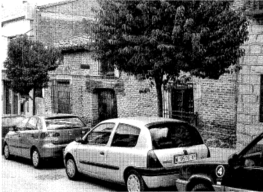
Casón en la calle del Limón Verde, 9. Vista general. Foto, Félix Cabrero, 2005.
