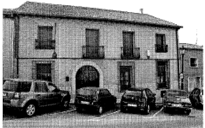
Edificio urbano muy transformado de la calle Mayor, 23. Foto, Jose Ablanado, 2008.
