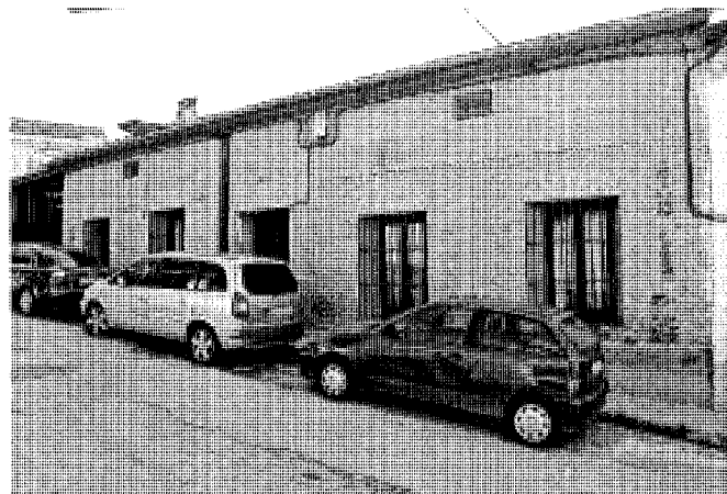
Casona rehabilitada de la calle de la Peña, 10. Foto, Jose Ablanedo, 2008.
