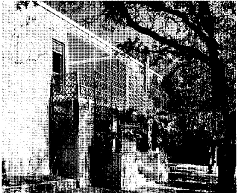
Fachada principal. Detalle por el acceso y patio. Foto cedida por el autor.
