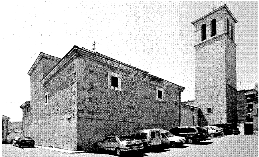
Vista exterior de la fachada norte.
