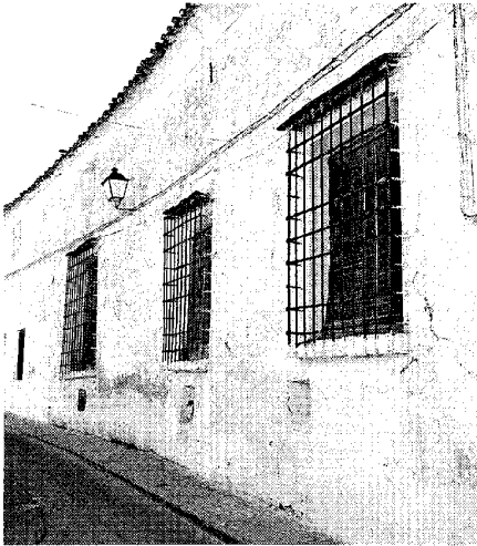
Vivienda en la calle Cañitas, 4.
