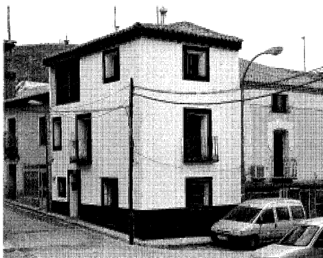
Vivienda rehabilitada en la travesía del Olmo, nº 2. Foto Vicente Patón.
