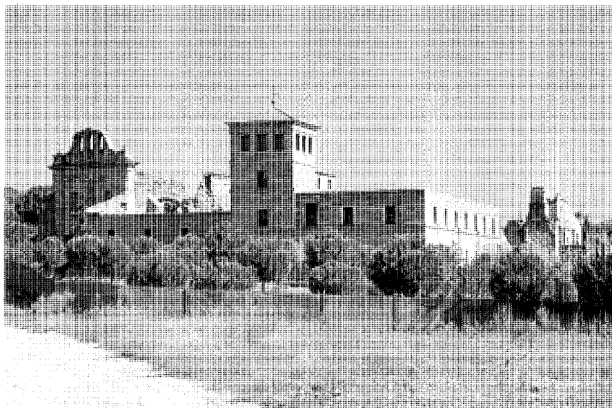
Vista del conjunto. Fot. Actividades y Servicios Fotográficos, S.A.
