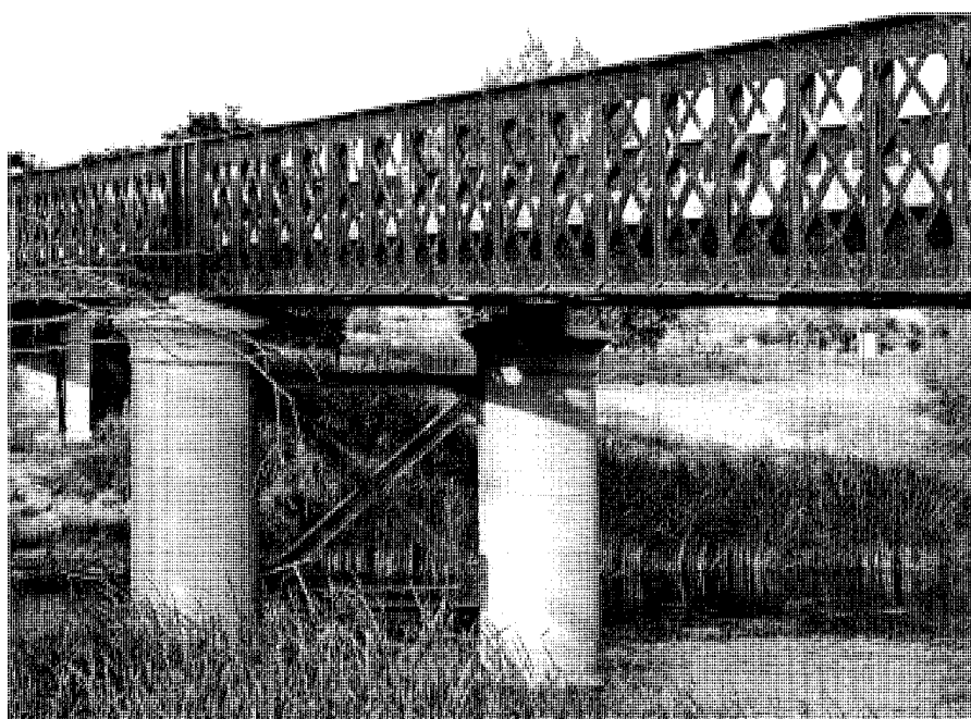
Detalle pilones centrales.
