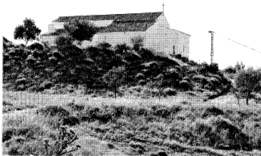
Ermita de N.ª S.ª de Alarilla desde la Cañada Real Soriana.
