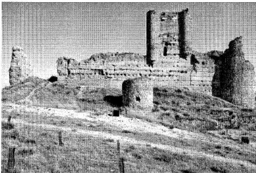
Fachada con Torre del Homenaje.
