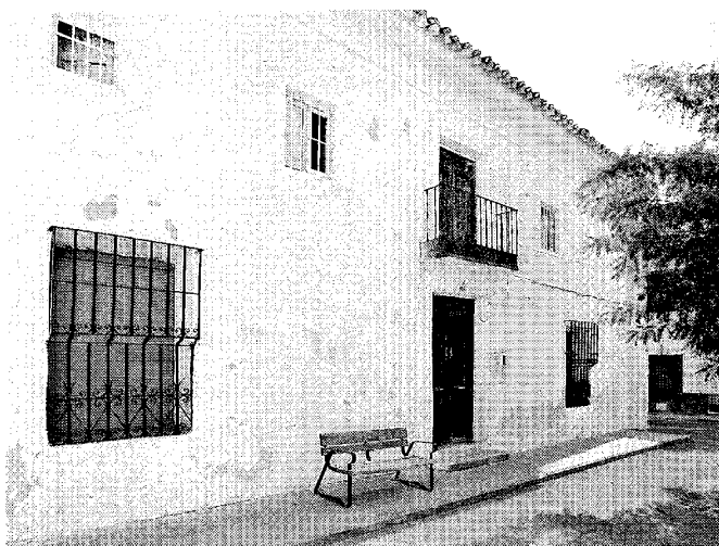
Detalle vivienda calle Mayor, 28.
