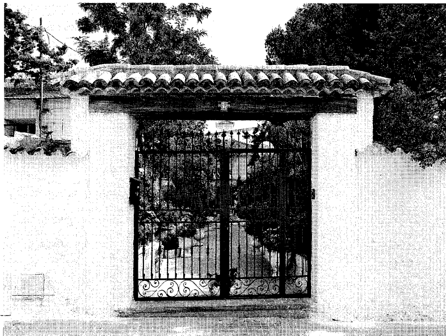
Entrada casa calle Mayor, 32.
