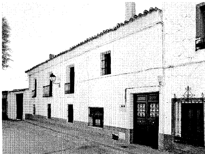
Vivienda en travesía de la Plazuela, 12.
