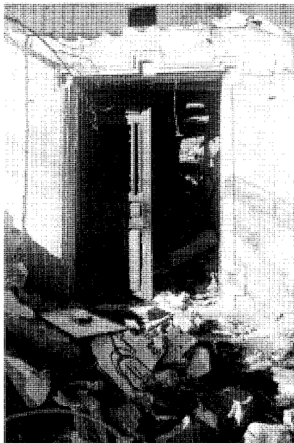
Vivienda arruinada en la calle de la Fuente nº 8. Año 1727. Fot. Natalia Torreblanca.
