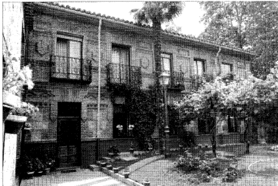
Edificio principal con jardín antepuesto. Estado actual.
