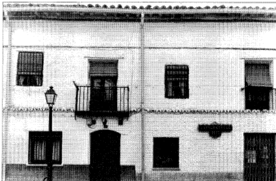
Fachada a la calle del Puente. Detalle del número 6.
