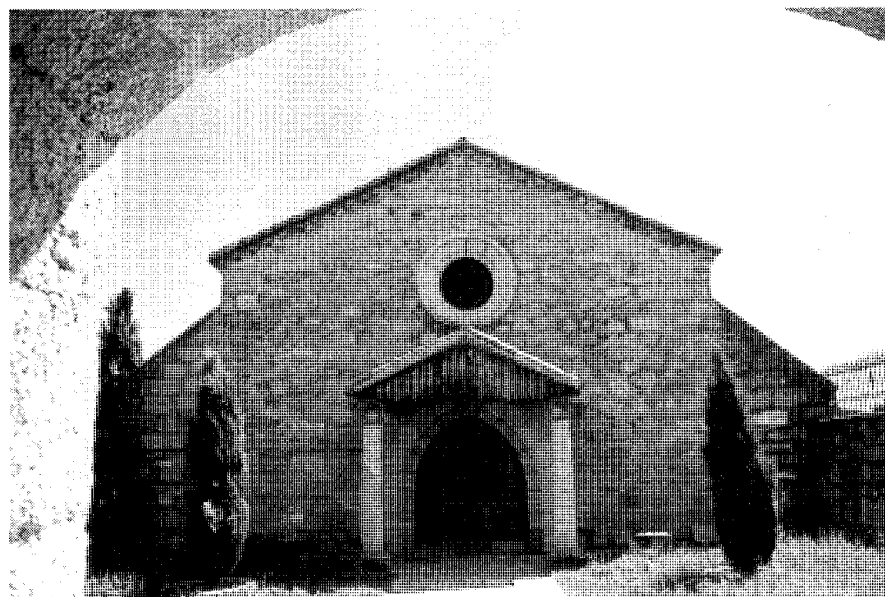
Fachada principal. Fot. Pilar Martín-Serrano.
