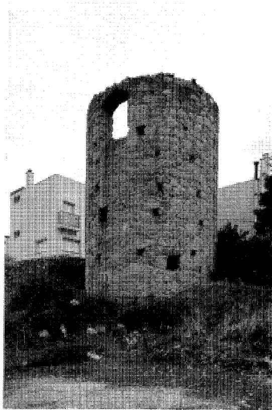
Torreón de la Bomba de la fábrica de loza . Fot. José Rodríguez Ablanedo.
