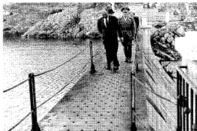
Inauguración por el general Franco de la presa del Aulencia. AGA Regiones Devastadas
