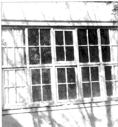
Detalle de la fachada de la Galería de Hombres.
