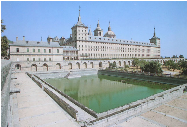
Vista de la fachada meridional con el estanque
