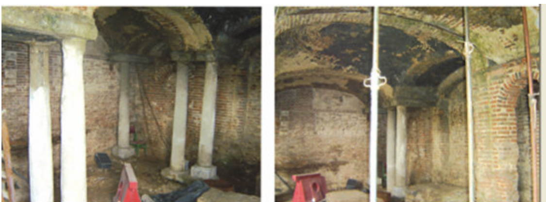
Estado actual del interior de la Galería de las Grutas. Fotos Ángela Souto
