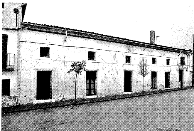
Vivienda en calle Santa Ana, 3. Foto Gonzalo López-Muñiz.
