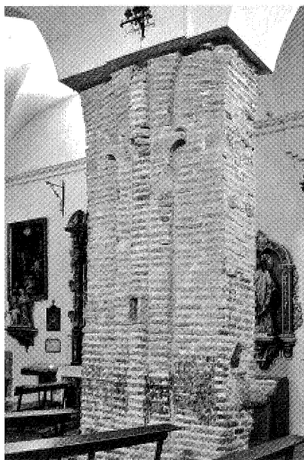
Pilar de la nave central de fábrica original de estilo mudéjar. Foto Gonzalo López-Muñiz.
