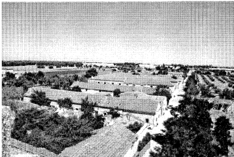
Vista del núcleo urbano hacia el norte. Foto Servicio Histórico, Fundación Arquitectura COAM.
