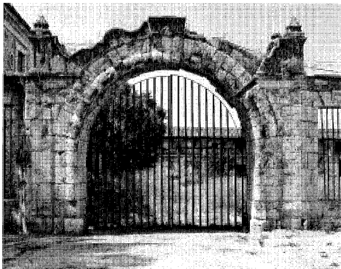
Vista del arco de acceso desde la plaza del Mercado.
