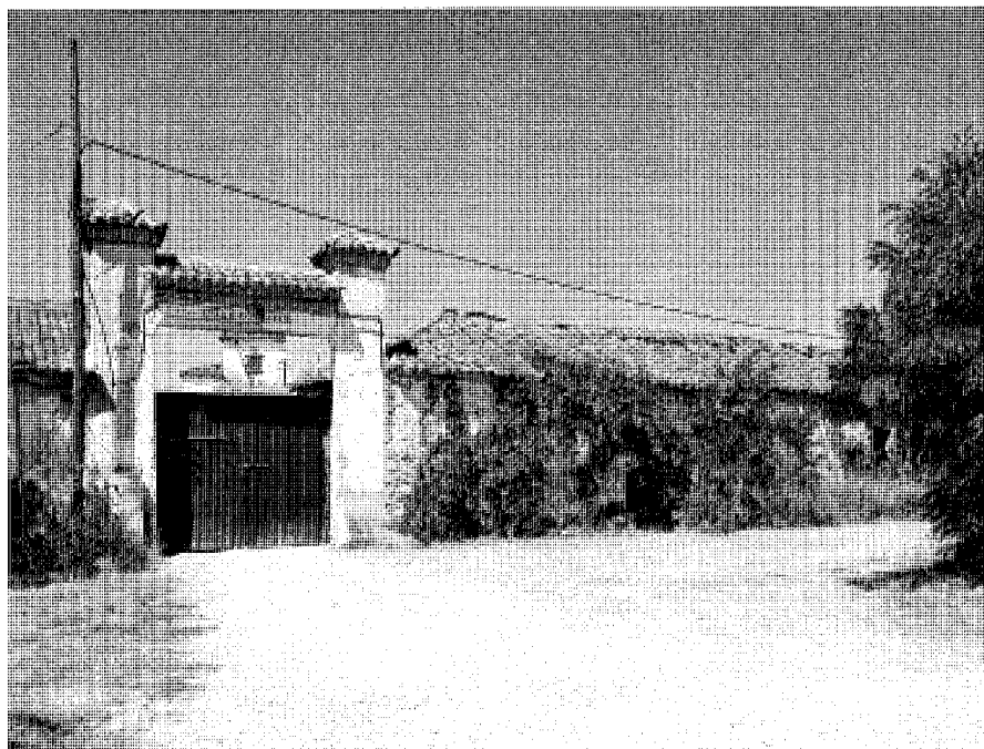
Vista de la portada exterior.
