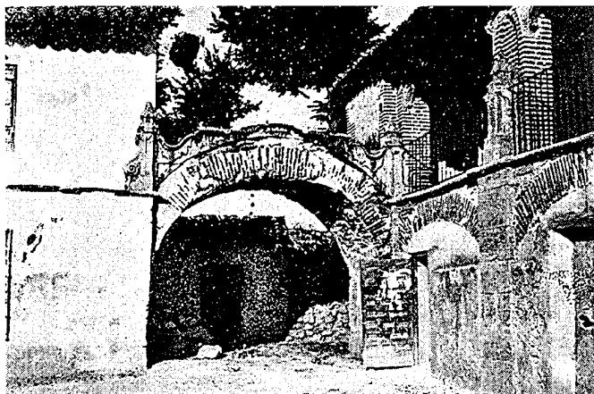
Vista del arco oriental de la plaza de Fiestas, 1932. Arquitectura , 1932.
