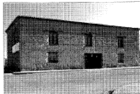
Vivienda en la calle de la Iglesia, 4
