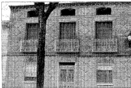
Vivienda en la calle Calvario, 18
