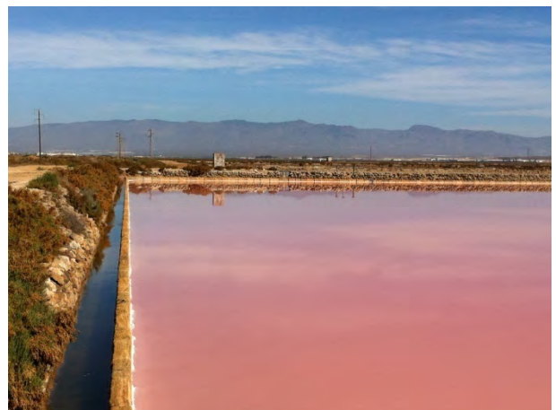
Canalizaciones y cristalizadores
