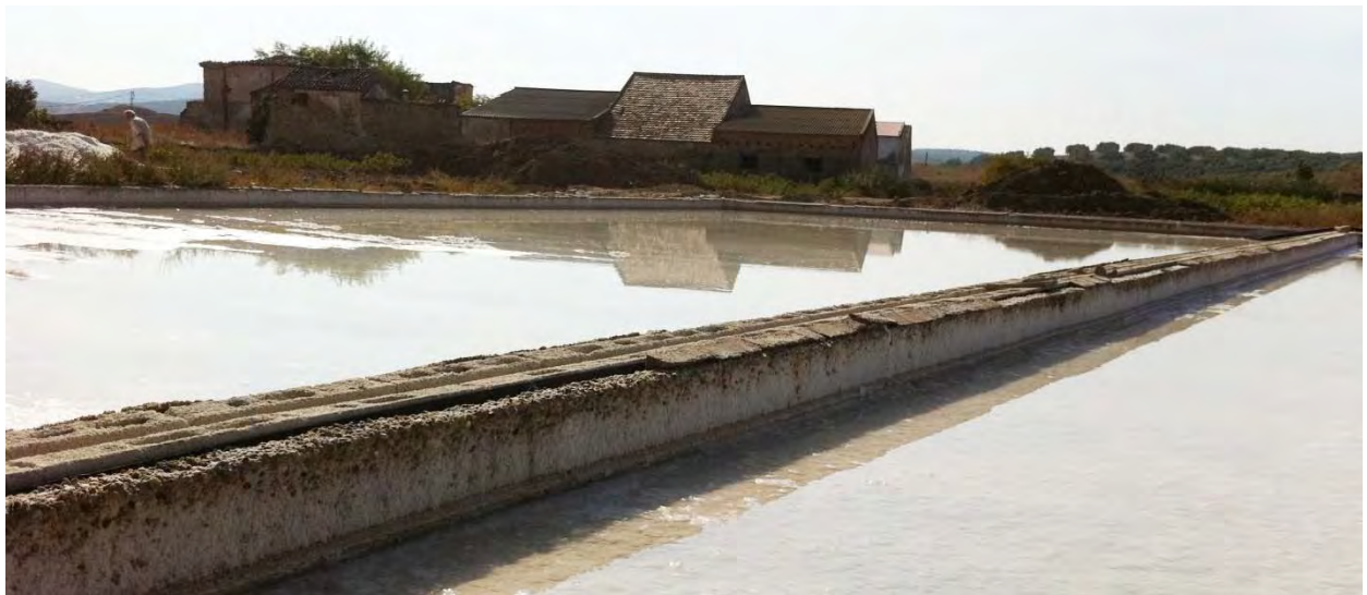
Conducciones y eras de evaporación con edificaciones salineras al fondo
