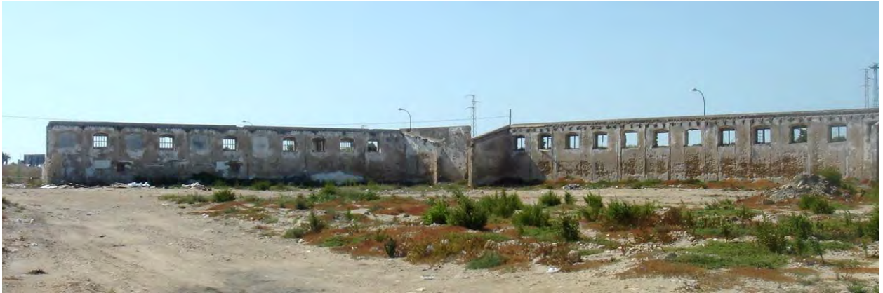
Restos de los almacenes de la explotación salinera
