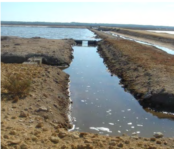
Canales de distribución y compuertas de paso
