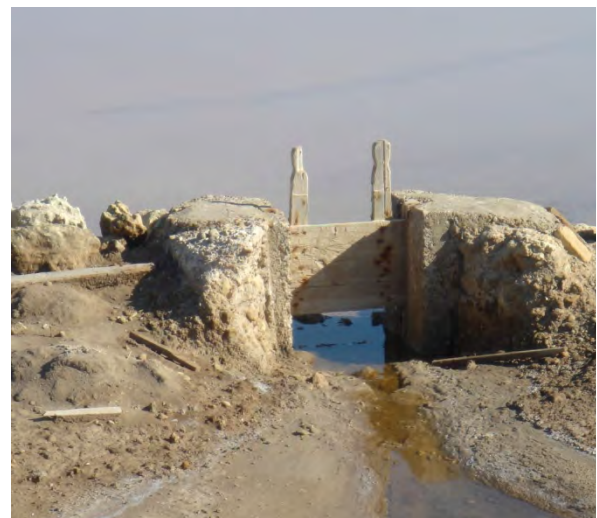
Detalle de compuerta de madera
