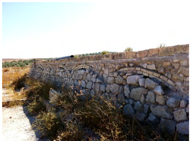
Muros de contención en piedra
