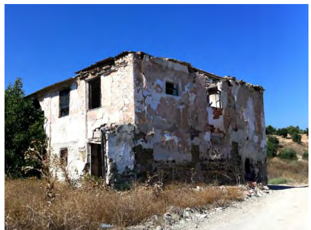
Casa salinera en ruinas
