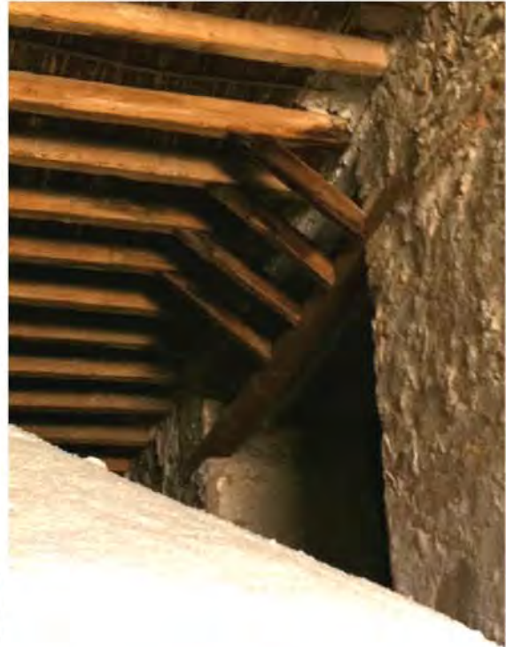
Detalle del interior del almacén de sal
