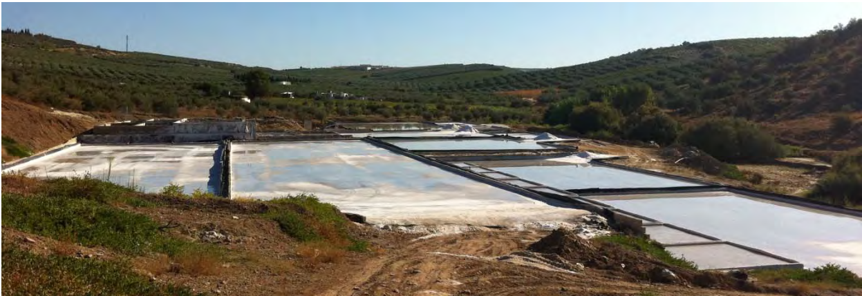
Vista general de la explotación. Se han destruido las trazas antiguas de las eras de evaporación
