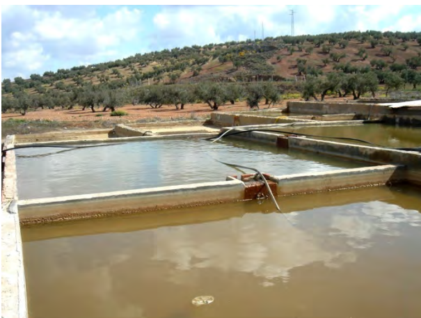
Eras de evaporación con mortero de cemento
