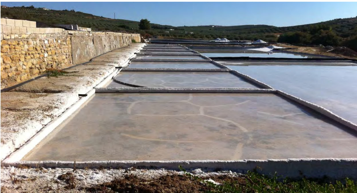
Eras de evaporación con trazado original y empleo de materiales modernos en la base
