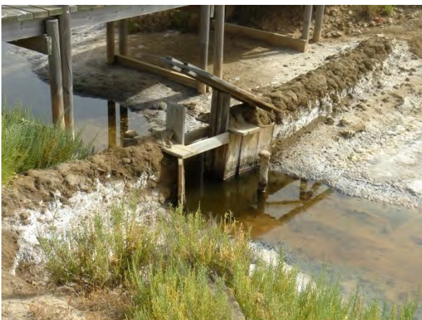
Detalle de compuerta de madera
