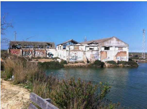
Almacenes y edificios auxiliares en ruina
