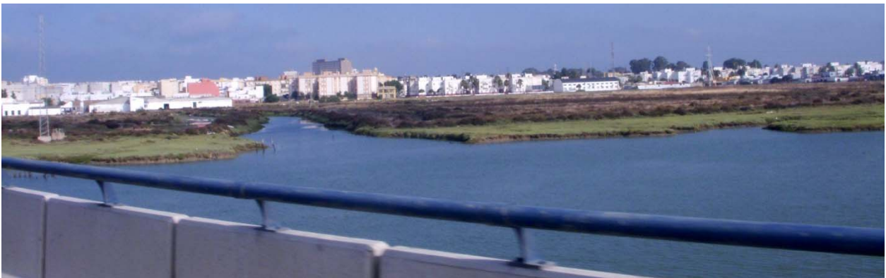
Vista general de la explotación desde la autovía. Al fondo San Fernando
