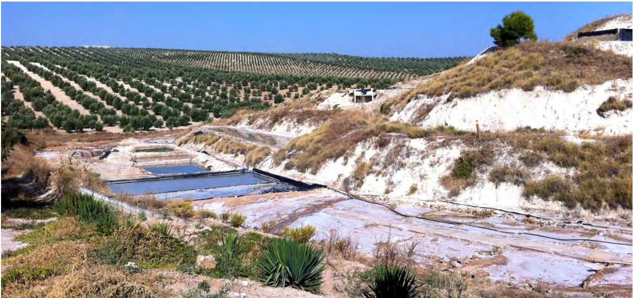
Eras de evaporación abandonadas. Empleo de materiales modernos. Adaptación a la topografía
