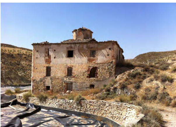
Fachada de casa-almacén en ruinas
