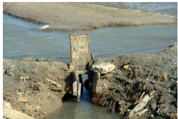
Detalle de compuerta de madera
