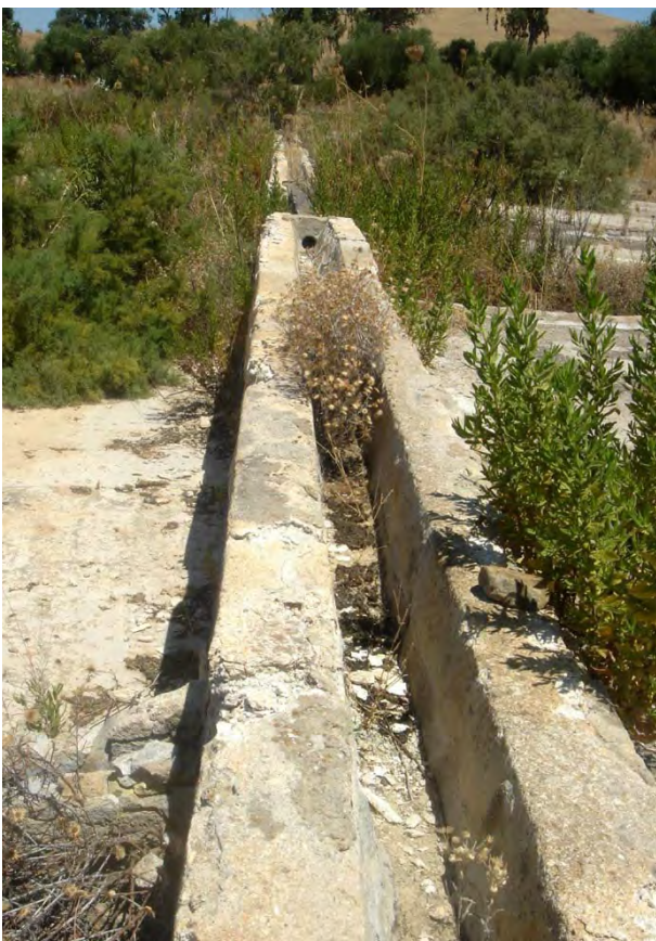
Canalización de la salmuera. Vegetación espontánea
