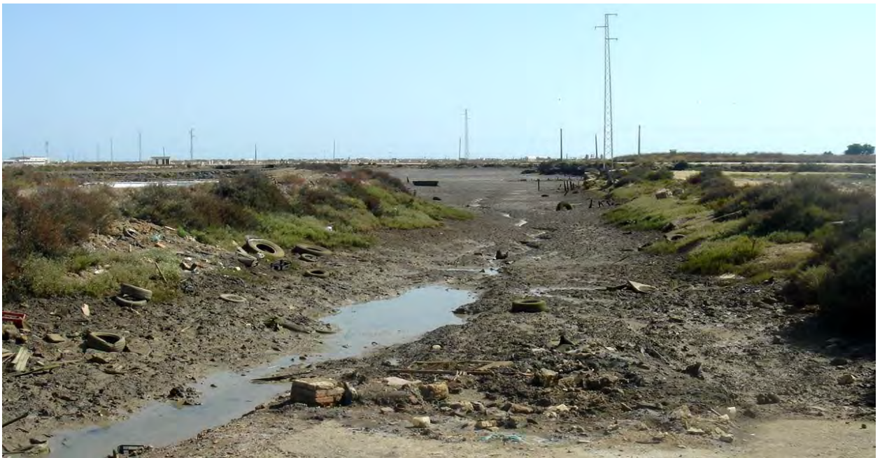
Restos de los canales y cristalizadores de la salina
