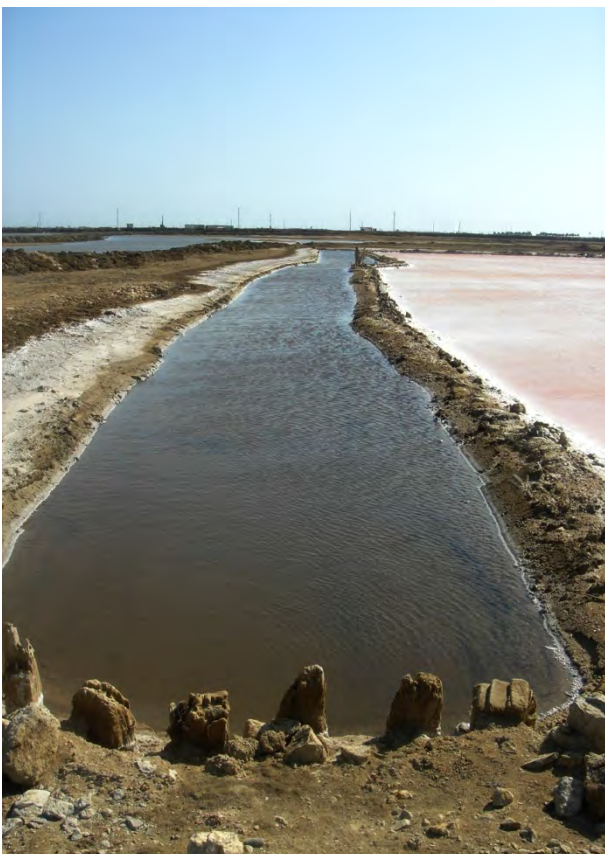
Vista general de la salina. Cristalizadores y caño
