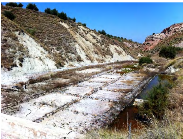
Eras de evaporación con acabado en piedra
