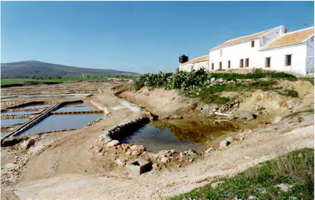
Vista general de la explotación. Eras de evaporación tradicionales y casa salinera
