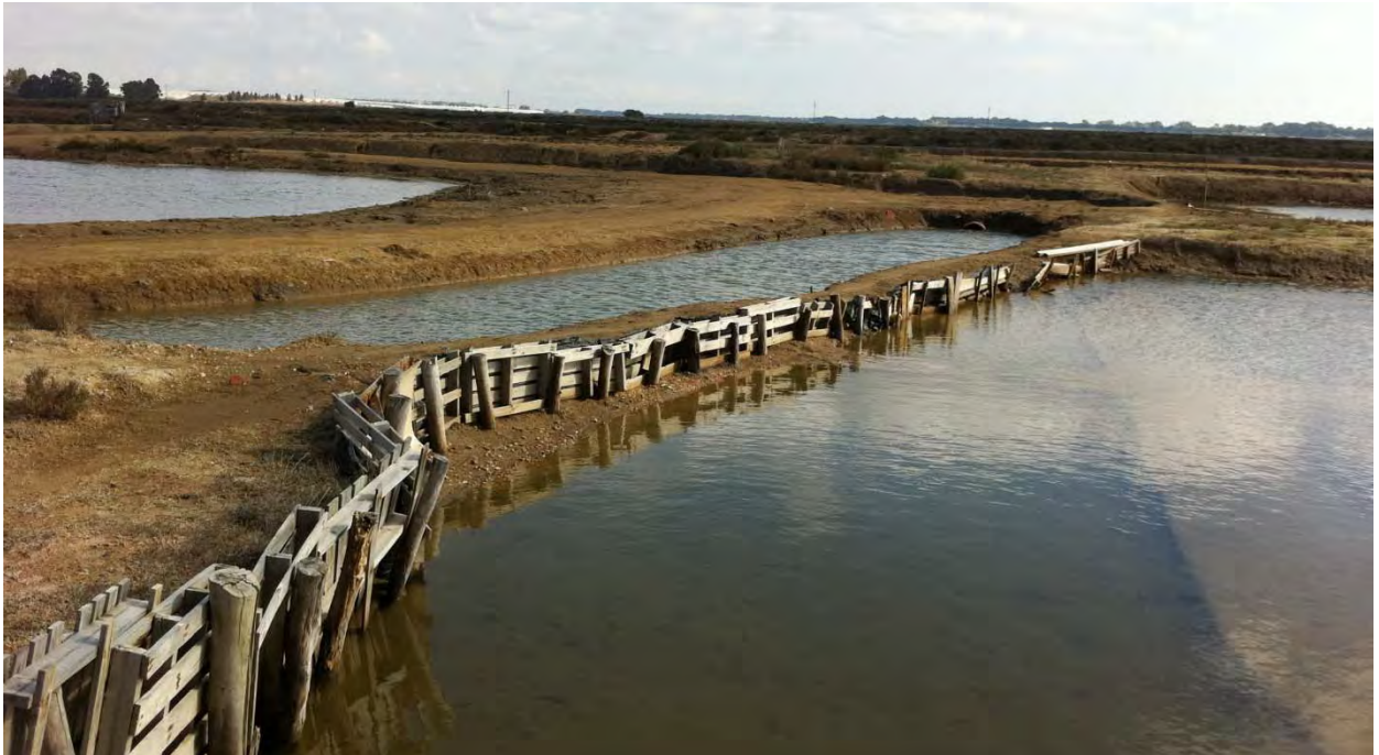
Detalle de construcción de los cristalizadores mediante entablado de madera
