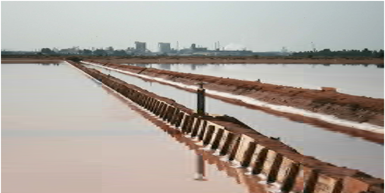
Vista general de los cristalizadores. Al fondo Polígono Industrial F. Montenegro
