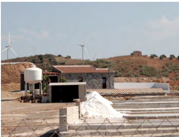
Construcciones modernas junto a las salinas
