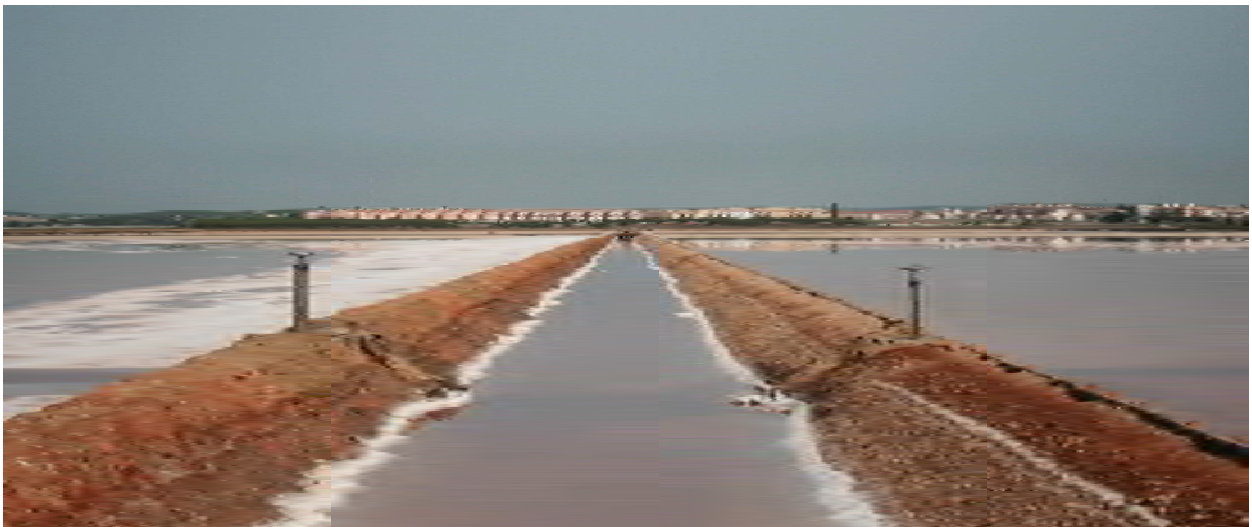
Cristalizadores, canalizaciones y al fondo zona residencial " El Redondel "
