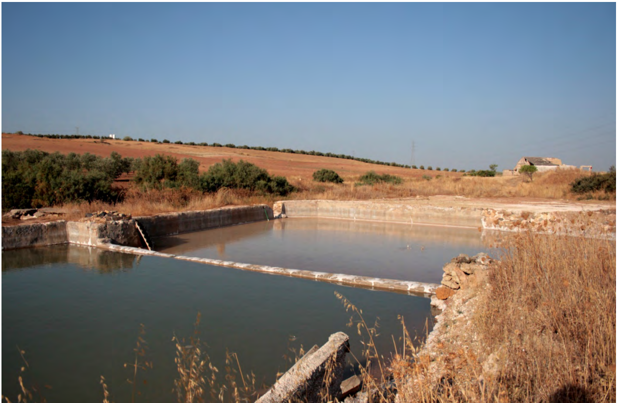
Calentadores para aumentar la concentración de sal. Al fondo casa salinera en ruinas
