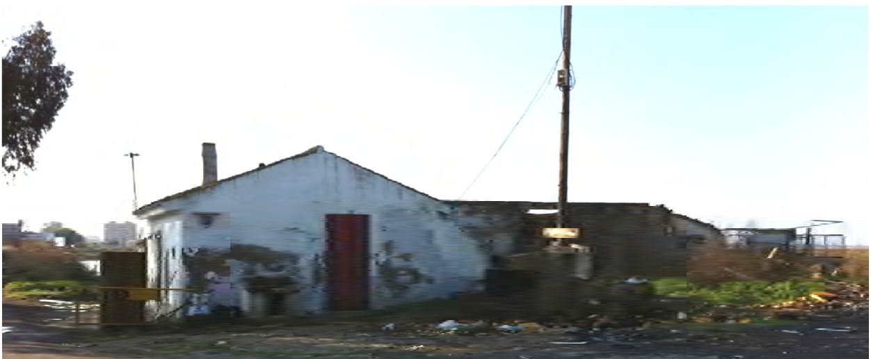
Restos de edificaciones y acumulación de residuos junto a las salinas
