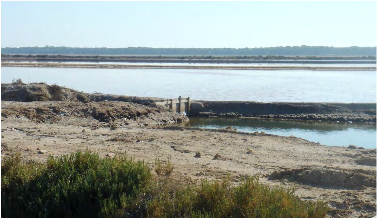
Vista general de la explotación. Compuertas de madera para regular el paso del agua
