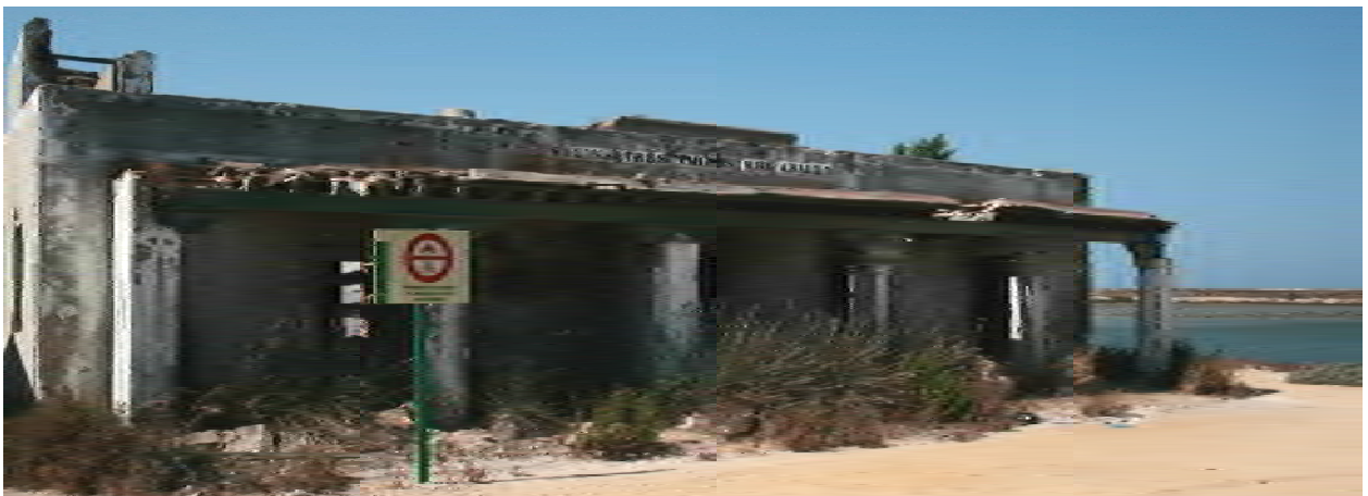
Fachada principal de la casa salinera en ruinas
