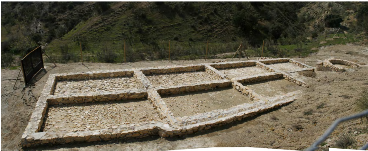
Eras de evaporación reconstruidas con métodos tradicionales
