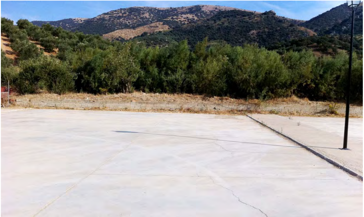
Solera de hormigón para aparcamiento sobre las antiguas eras de evaporación
