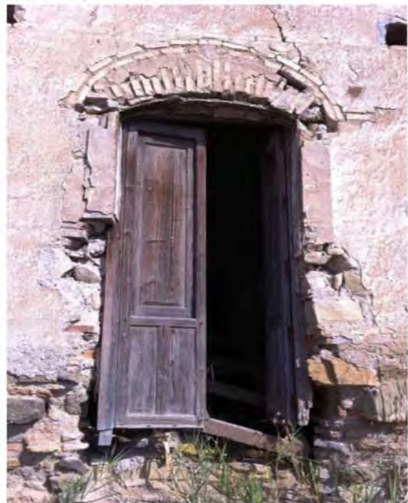
Detalle de puerta de acceso a las oficinas
