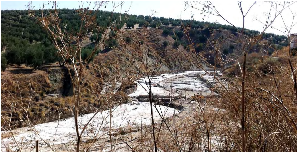
Adaptación de las eras de evaporación a la morfología del barranco
