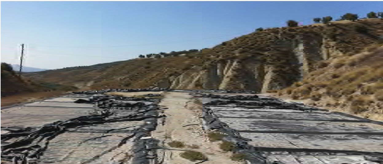
Eras de evaporación abandonadas. Empleo de materiales modernos: láminas impermeabilizantes.
