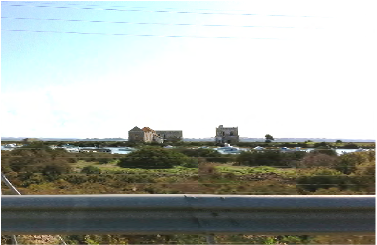
Vista general de la explotación desde la autovía
