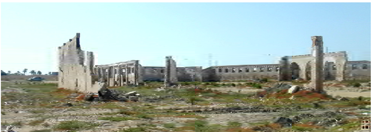
Edificaciones en ruina de la explotación salinera
