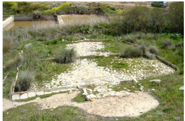
Empedrado en eras de evaporación abandonadas
