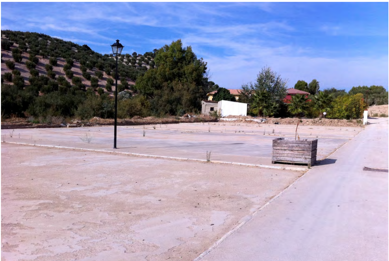
Solera de hormigón para aparcamiento sobre las antiguas eras de evaporación
