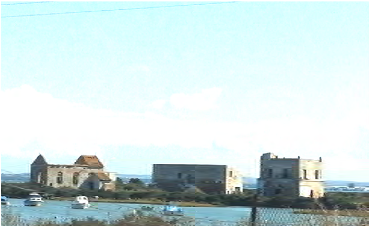
Ruinas de edificios de viviendas y casa de administración de las salinas
