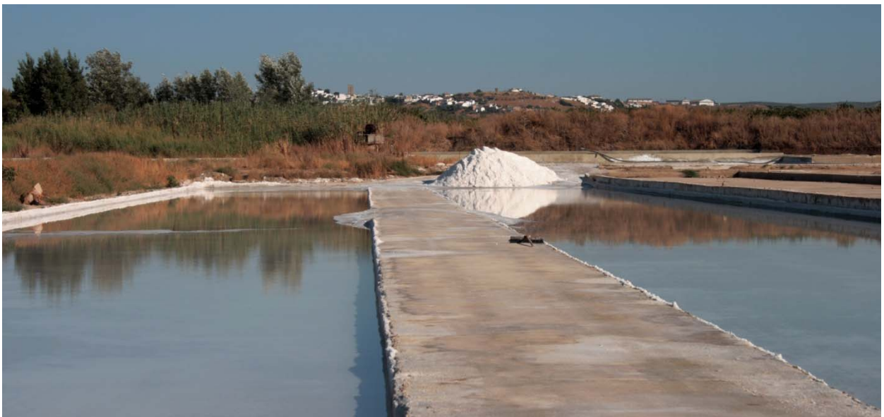
Eras de evaporación y espacios para el secado de la sal. Aplicación de materiales modernos (mortero cemento)
