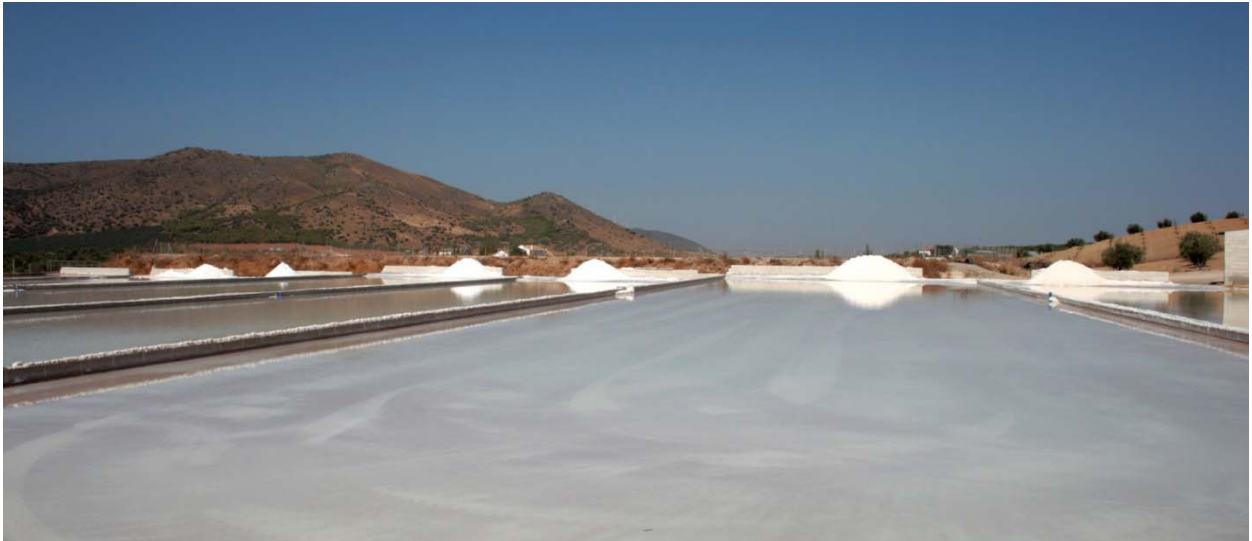
Vista general de las eras de evaporación. Destrucción de las trazas originales y empleo de materiales modernos
