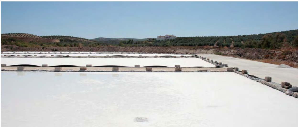
Eras de evaporación construidas con materiales modernos: láminas impermeabilizantes y bloques de hormigón
