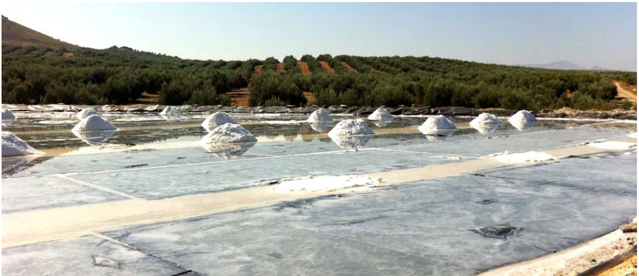
Montones de sal para el secado. Empleo de láminas impermeabilizantes
