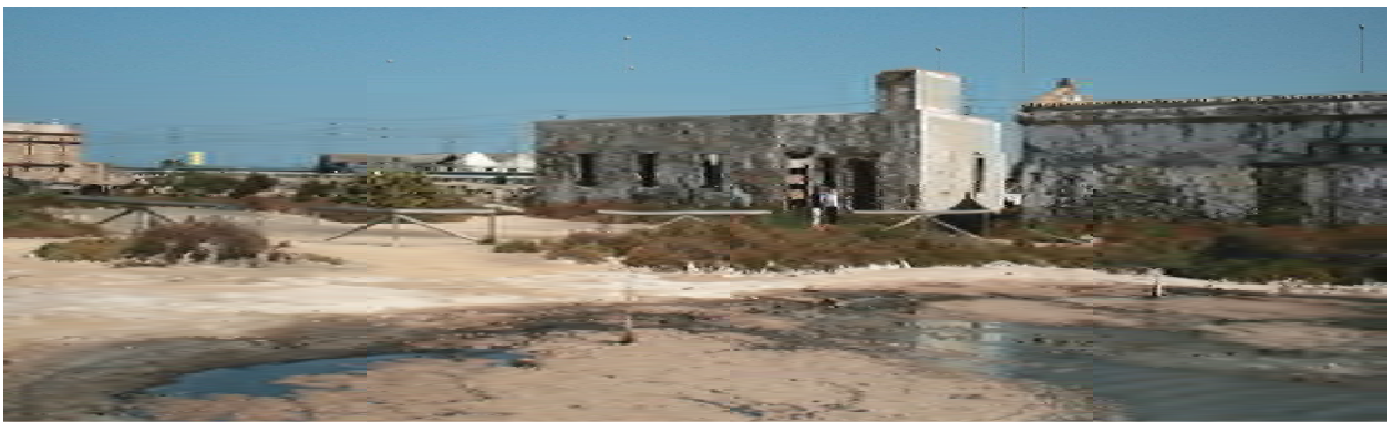
Fachadas posteriores de las casas salineras en ruinas
