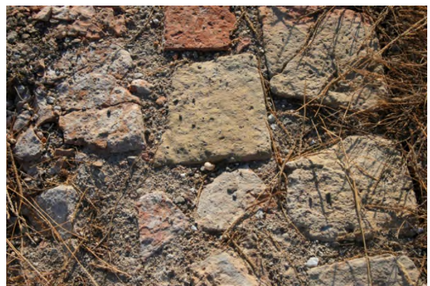
Detalle de acabado de las eras
