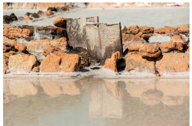
Detalle de compuerta de madera
