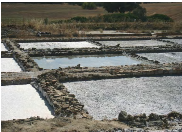
Detalle de las eras de evaporación
