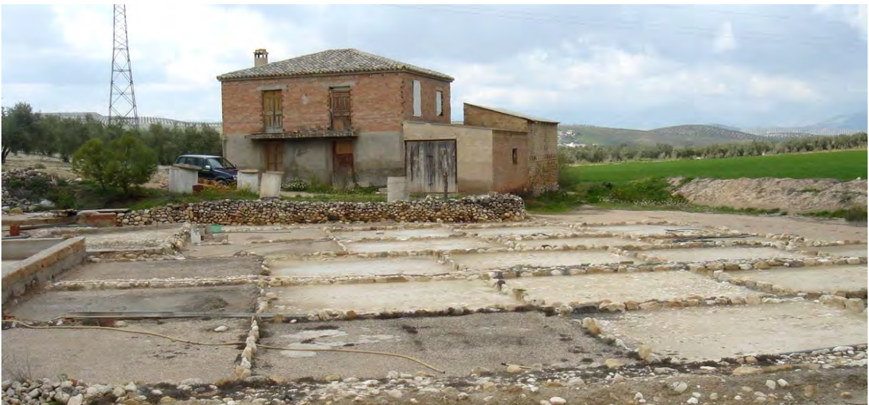
Eras de vaporación y casa salinera reconstruida con materiales modernos
