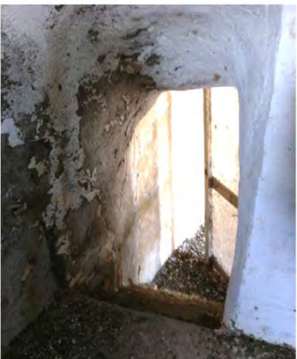
Interior de la torre-vigía
