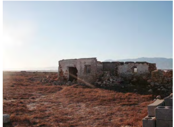
Casa salinera en ruinas
