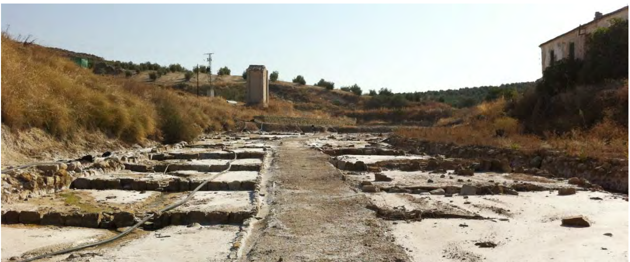
Eras de evaporación adaptándose a la topografía del entorno
