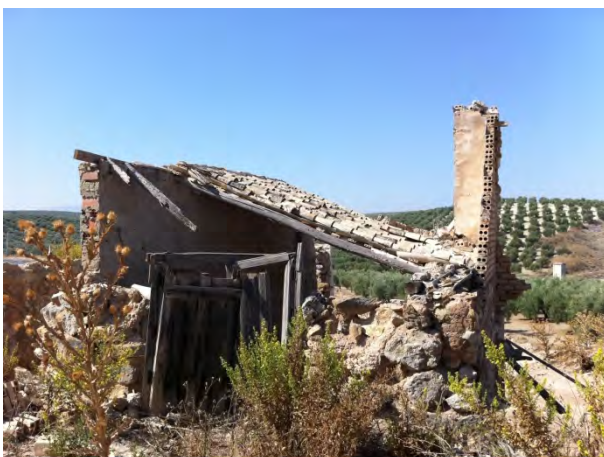
Construcciones salineras en ruinas
