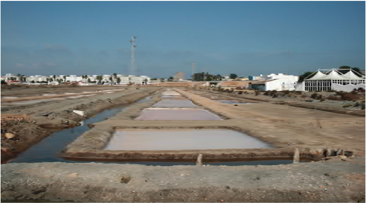
Vista general de la instalación. Cristalizadores y conducciones de salmuera
