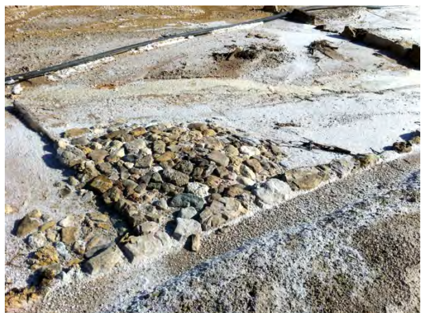
Detalle de era de evaporación y superficie de secado
