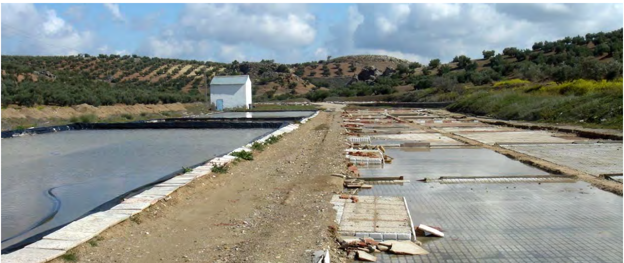
Eras de evaporación con aplicación de materiales nuevos (aplacado cerámico)
