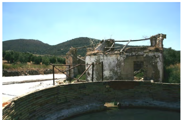
Pozo y edificación en ruinas
