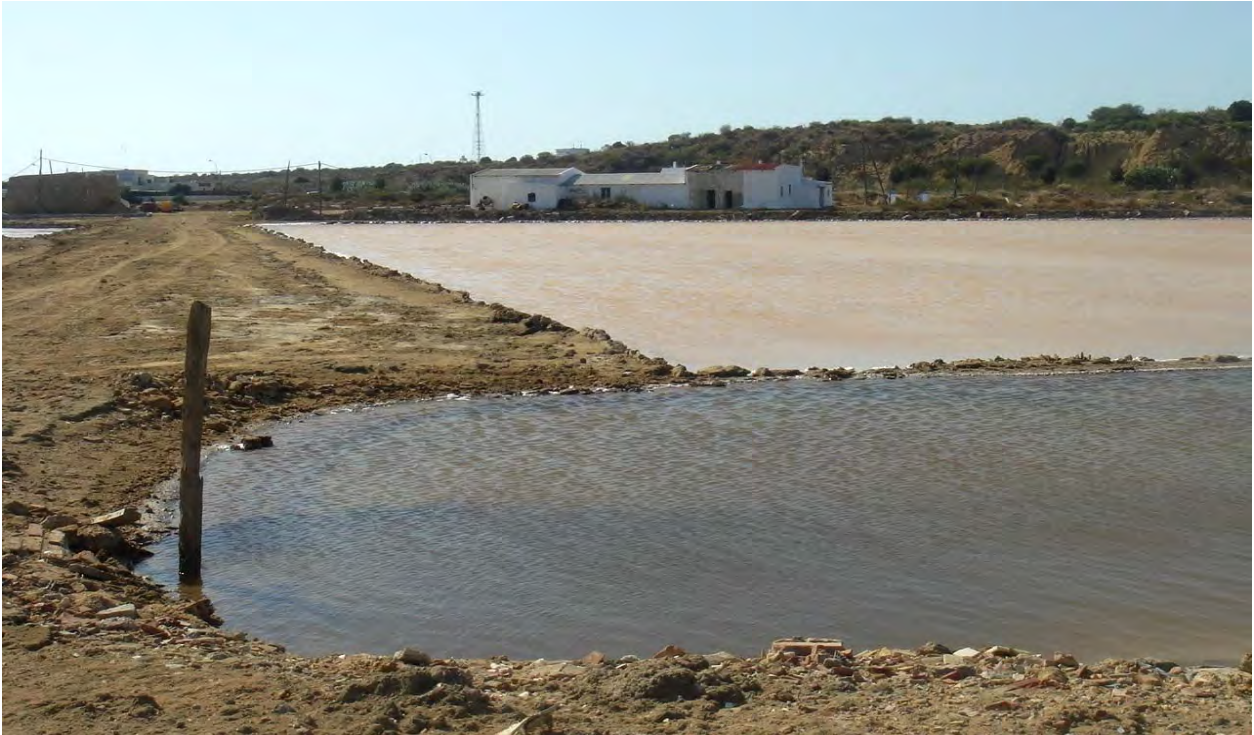
Vista general de la salina. Casa salinera al fondo
