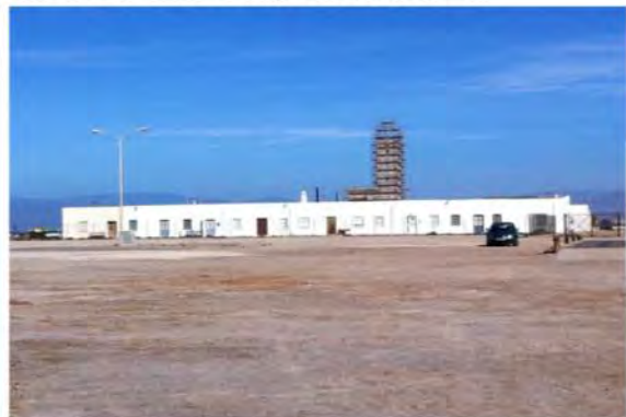
Viviendas y edificios anejos a la explotación
