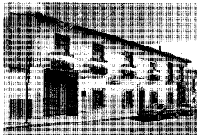
Vivienda en calle Domingo Rodelgo, 19-23.
