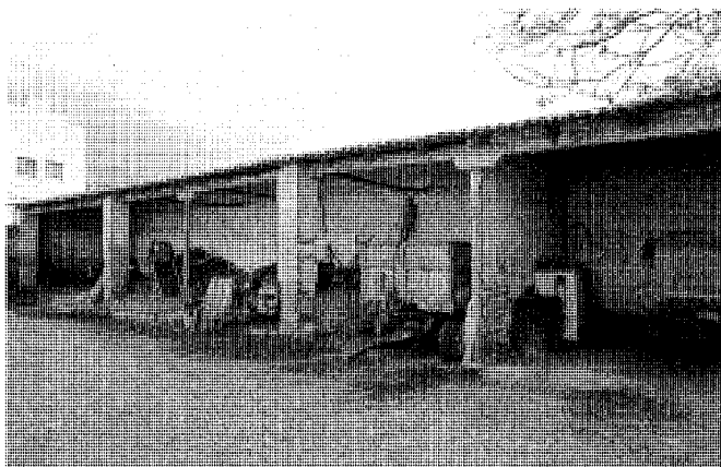
Patio interior del conjunto agropecuario en calle Carmen, 26 c/v calle Mediodía.
