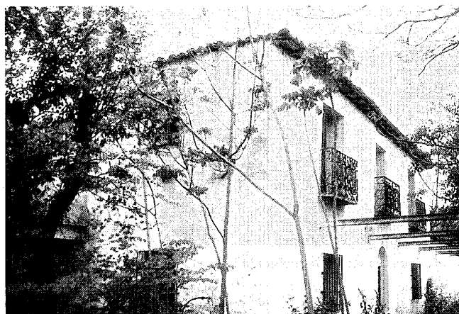
Parador de Frascuelo, al oeste de la población. Vista del edificio principal. Foto: Virginia Torres.
