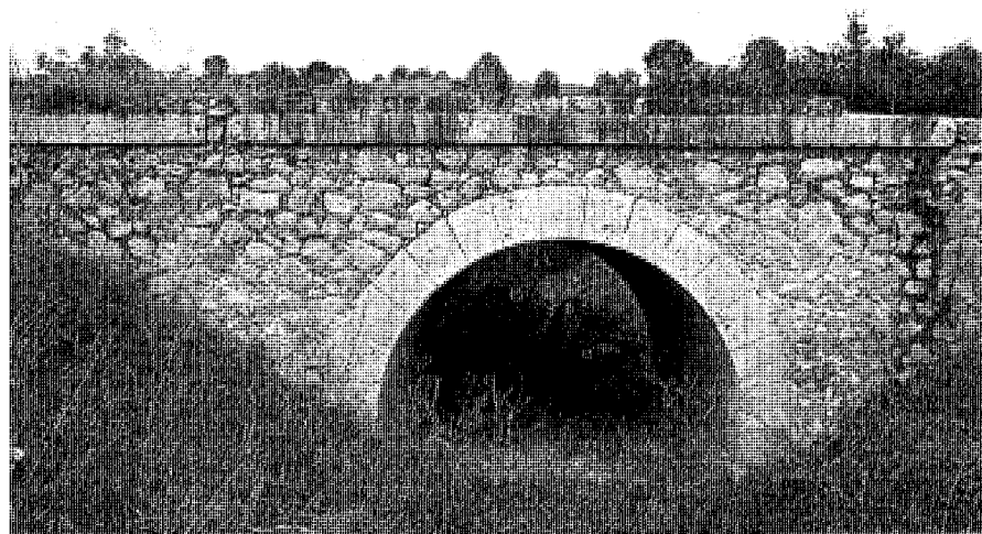
Puente de piedra en antigua carretera a Morata.
