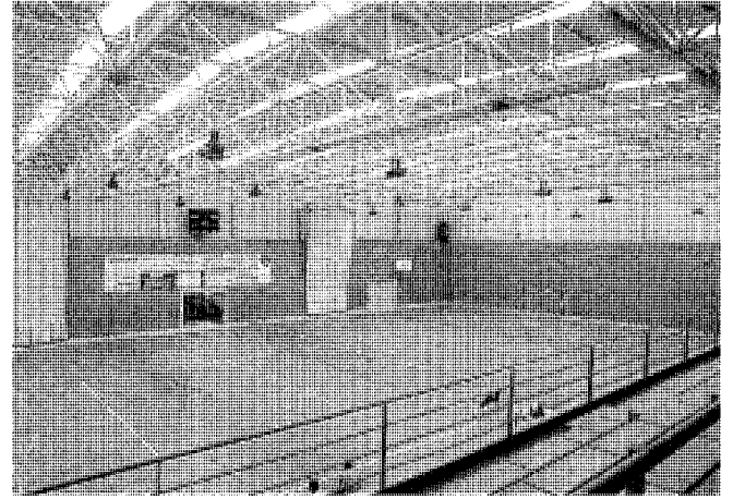
Vista interior de la pista del polideportivo municipal. Arquitecto: Manuel Canalda.
