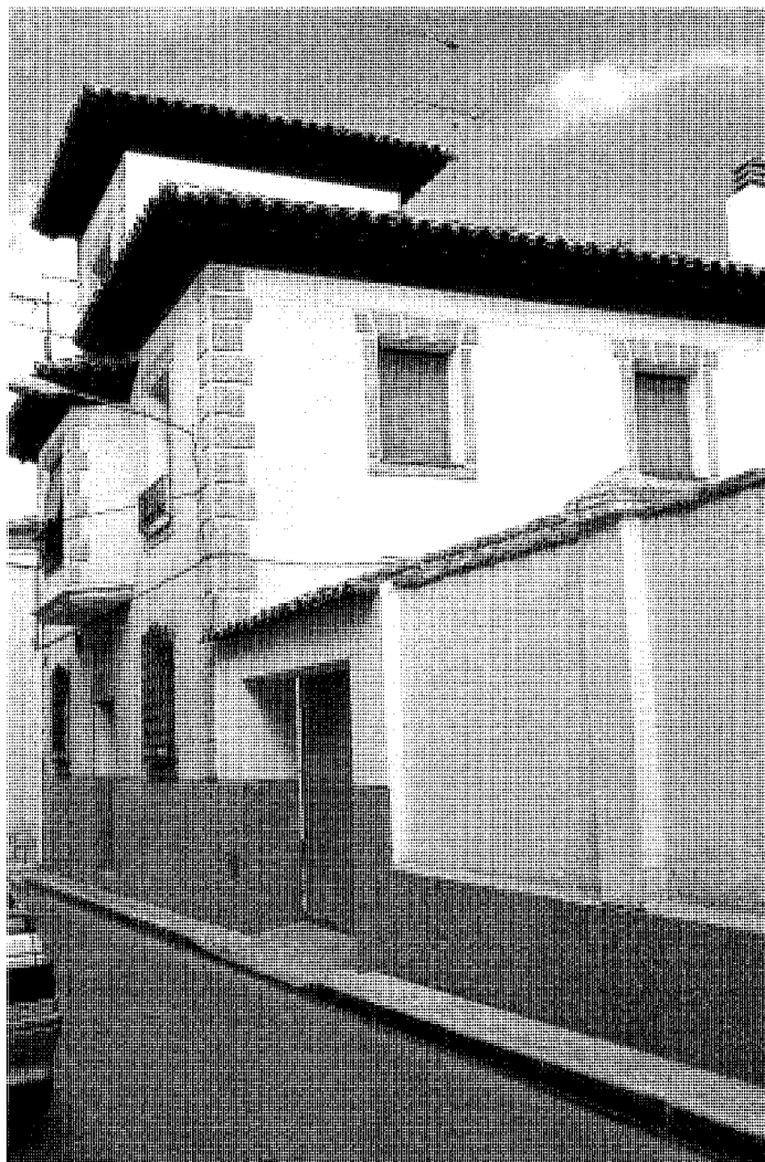
Vivienda en calle Colmenares, 3.
