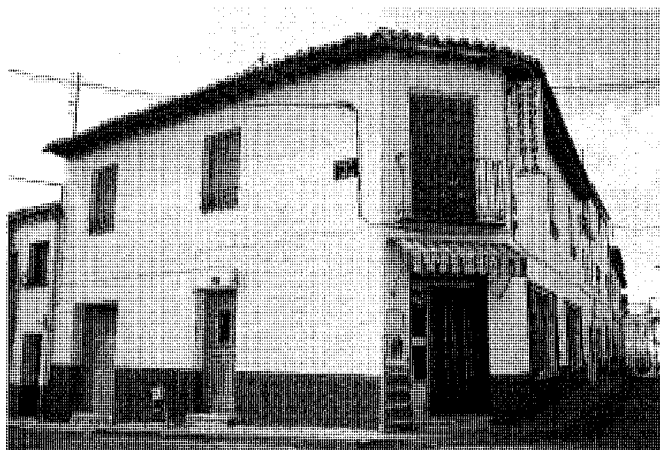
Vivienda en calle del Centro, 17 c/v calle del Ciego.
