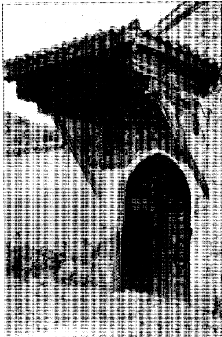
Hospital de San Salvador. (Desaparecido). Portada oeste en 1927. Revista Arquitectura
