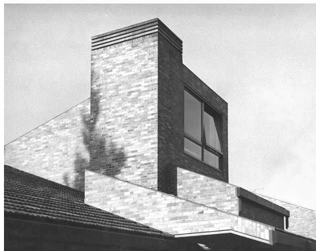
Figura 12. Casa Huarte. El aparejo del ladrillo cambia de soga a sardinel en el revestimiento del voladizo del porche. Fotografía: Archivo Huarte
