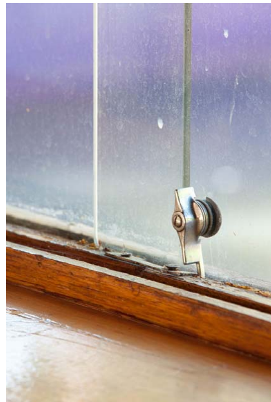
Casa Huarte. Detalles de las ventanas correderas tipo Pierson. Octubre 2011. Fotografías: Miguel de Guzmán.
