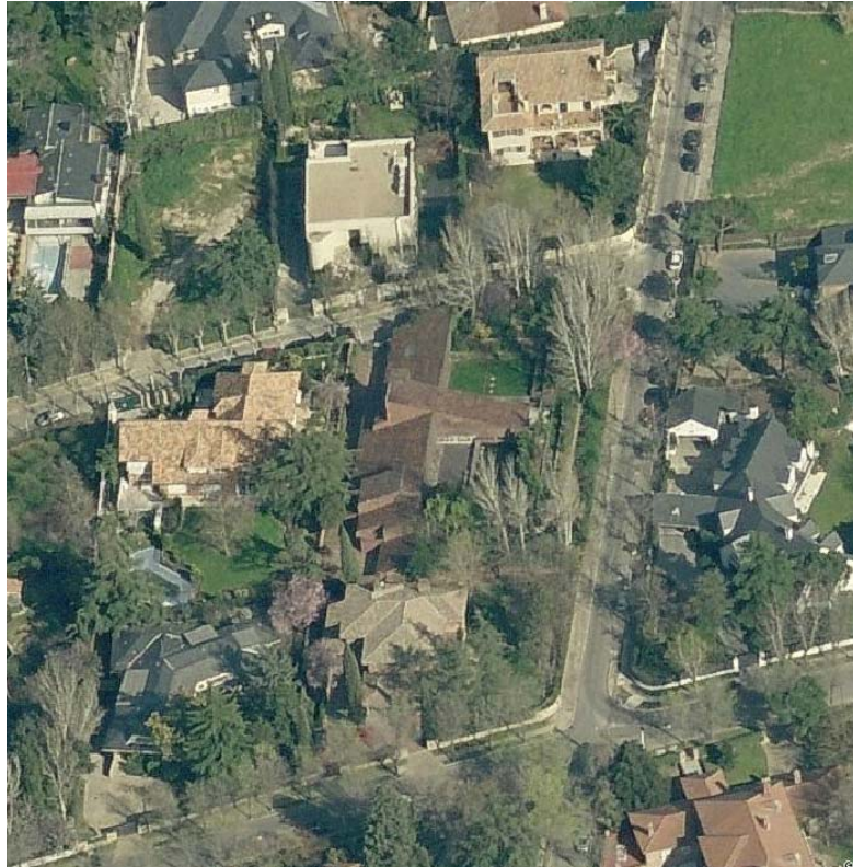
CASA HUARTE. FOTOGRAFÍA AEREA. PERSPECTIVA OESTE. ESTADO ACTUAL, 2013
