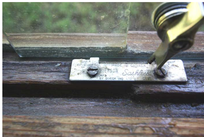
Casa Huarte. Sistema de cerramiento de las ventanas tipo Pierson, una patente canadiense según se lee en la inscripción. Corrales y Molezún se referían a la patente como Pearson de origen inglés. Fotografía: Pablo Olalquiaga
