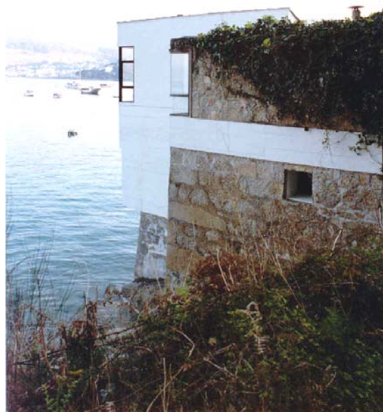
Molezún. La Roiba. Vista hacia la Ría desde el camino después de la ampliación de 1975
