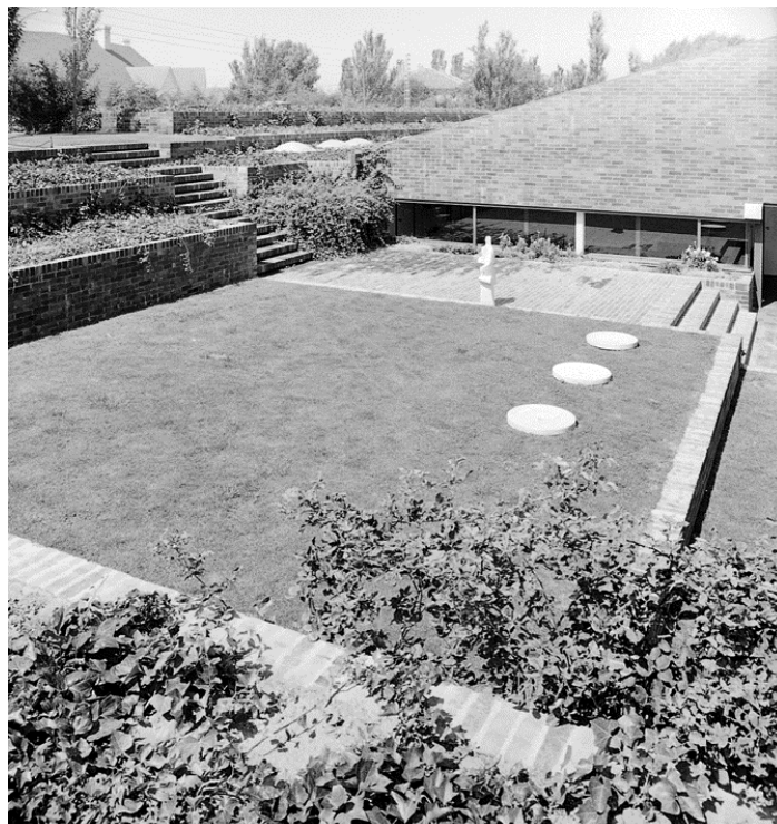
Casa Huarte. Patio de padres o de relación. Atectónica materia y constructiva. El ladrillo en aparejo a soga se utiliza tanto en los muros de contención y las escaleras del patio como en el paño suspendido del volumen de la biblioteca. Fotografía: Legado Vázquez Molezún. Fundación COAM
