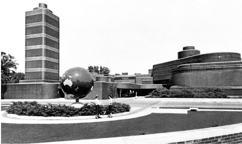
Figura 9. F. Ll. Wright. Edificio para Johnson Wax Racine, Wisconsin. 1936. Atectónica. El ladrillo en aparejo a soga se utiliza tanto en los muros ciegos de cerramiento que van hasta el suelo como en los dinteles de la zona de entrada y en los antepechos de la torre de oficinas. Fotografía publicada en "Frank Lloyd Wright. From within outward". Catálogo de la Exposición. Guggenheim Museum. Frank Lloyd Wright Foundation, Skira Rizzoli, 2009
