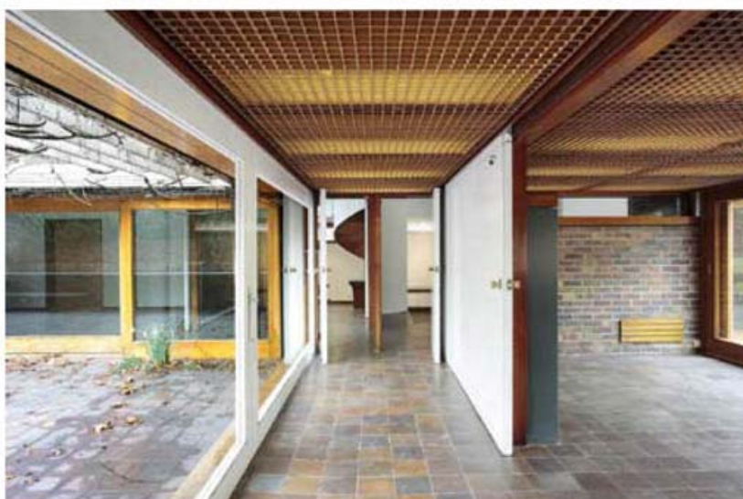
Casa Huarte. Opciones de comunicación entre los distintos espacios interiores y exteriores alrededor del porche. Las ventanas correderas que dan al patio de hijos desde el corredor y desde el vestíbulo de entrada eran paneles opacos con una estrecha ventana corrida translúcida en origen. Fotografías: José Hevia. Fuente "Documentos. Casa Huarte". Fundación Docomomo Ibérico. Disponible en www.docomomoiberico.com
