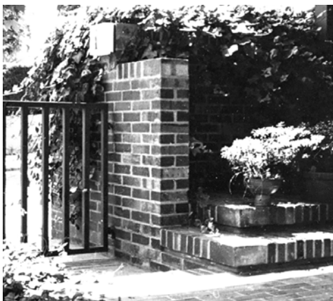
Figura 16. Casa Huarte. Detalle de peldaño en la zona de entrada y en el patio de servicio donde se observa que la altura del peldaño coincide con dos hiladas de ladrillo de la fachada. Fotografías: Archivo Huarte
