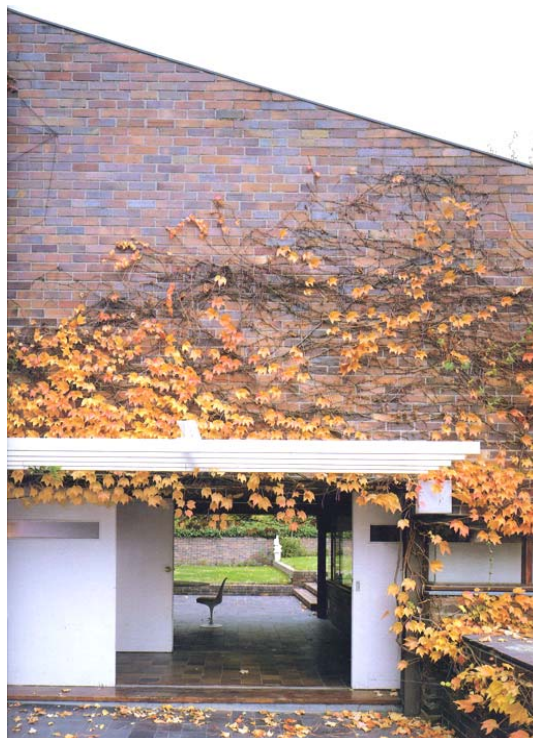
Casa Huarte. Detalle de fachada. Patio de hijos. Fotografía: Ángel Baltanás. Publicada en "Corrales y Molezún. Medalla de Oro de la Arquitectura 1992". CSCAE. 1993
