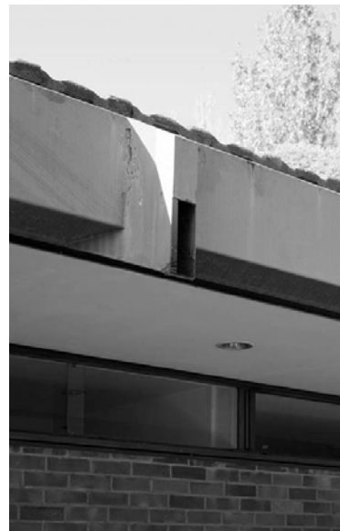
Figura 21. Izquierda: Detalle de encuentro de cubierta con canalón y falso techo del porche de entrada. Dibujo publicado en Nueva Forma 20, septiembre 1967. Derecha: detalle de gárgola en el canalón del porche, Fotografía: Miguel de Guzmán
