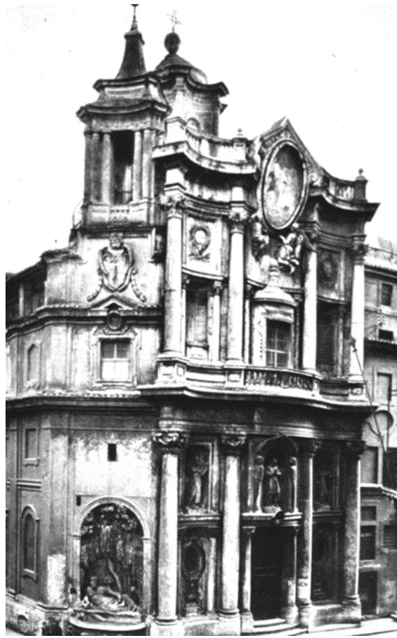
Figura 8. Borromini. San Carlo alle Quattro Fontane. Roma. 1638. Vista exterior. Doble juego de escalas. Por un lado la fachada de acceso con dos columnatas superpuestas de orden doble Chafán, por otro la fachada secundaria con huecos simples
