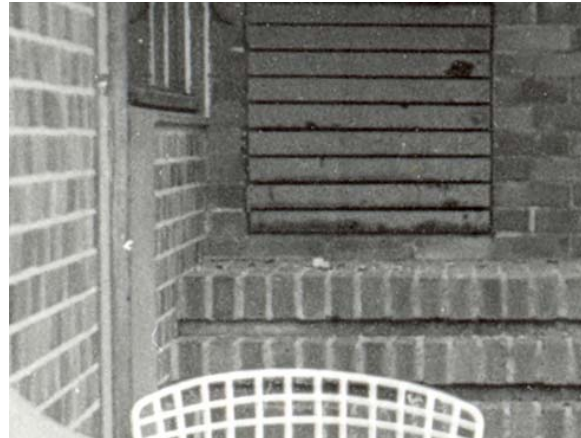
Figura 16. Casa Huarte. Detalle de peldaño en la zona de entrada y en el patio de servicio donde se observa que la altura del peldaño coincide con dos hiladas de ladrillo de la fachada. Fotografías: Archivo Huarte
