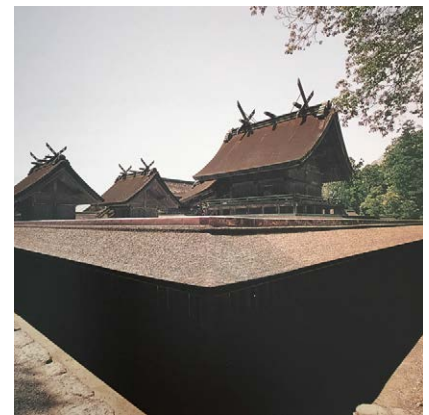
Fig.3.24 Cerramiento de Izumo Shrine Main Hall, Izumo, Prefectura de Shimane
