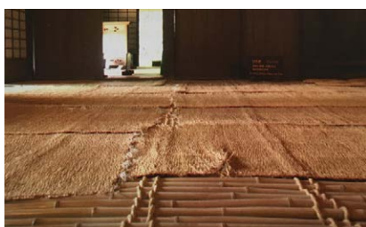
Fig.3.1 Casa Kitamura. Prefectura de Kanagawa. 1678 Suelo de tierra cubierto con tallos de bambú. Actualmente desmontada y trasladada al Museo de Arquitectura al aire libre Nihon Minka-en, Prefectura de Kanagawa
