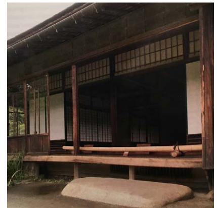
Fig.3.2 Kutsunugi-ishi a la entrada de Rinshunkaku, villa construida en 1649 durante el periodo Edo y trasladada al parque Sankei-en en 1917.
