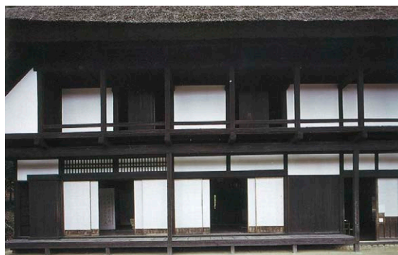
Fig.3.45 Fachada de shōji , Villa Tomizawa, Prefectura de Gumma.
