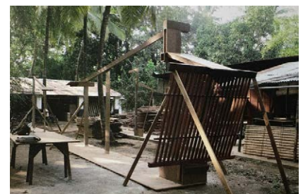
Fig.6.2.3 Maqueta a escala 1:1 de una fachada en las instalaciones del Studio Mumbai
