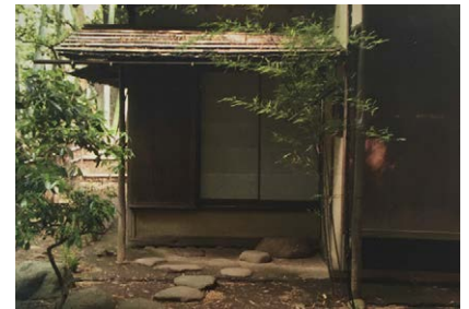
Fig.3.19 Dobisashi de acceso a casa de té Shunsōro, parque Sankei-en, Yokohama
