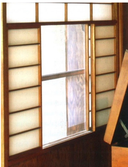
Fig.3.42 Detalle de nekomashōji , con paneles deslizantes hacia los lados, casa museo de Michi Miyagi.
