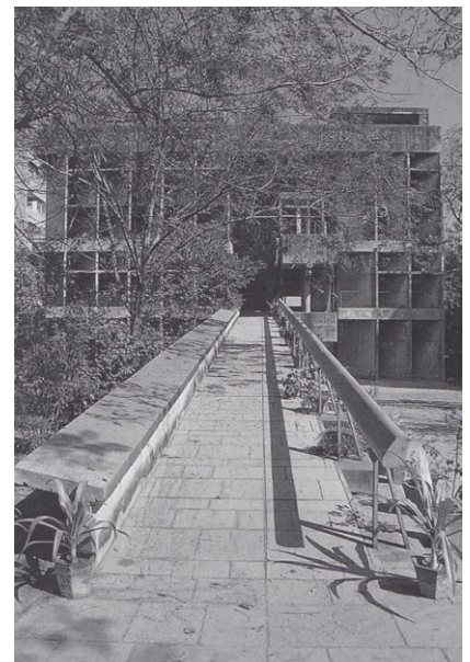
Fig.4.1.11 Palacio de los Hilanderos . Ahmedabad, India. 1954. Rampa de acceso, fachada oeste.
