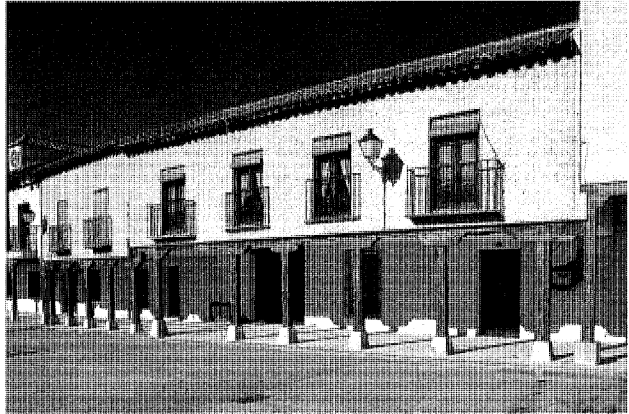
Fachada sur. Foto: Jose Ablanedo.
