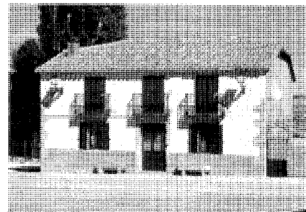
Vivienda en la plaza de la Constitución nº 5. Fot: Actividades y Servicios Fotográficos S.A.
