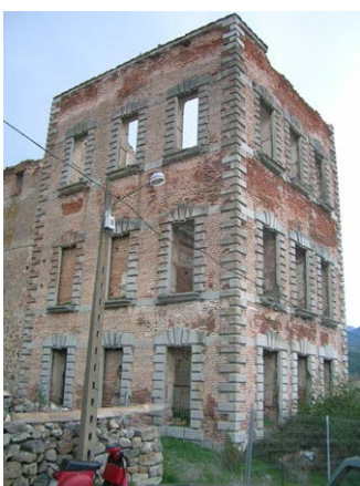
Vista de la Torre Nueva
