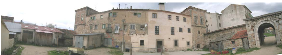
Vista de las casas de oficios desde el Patio de Vacas, con la tribuna real
