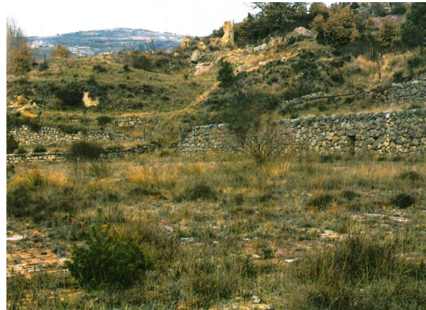
Figura 116. Eras de evaporación y muros de piedra para aterrazamientos en El Salí, finales del s. XX
