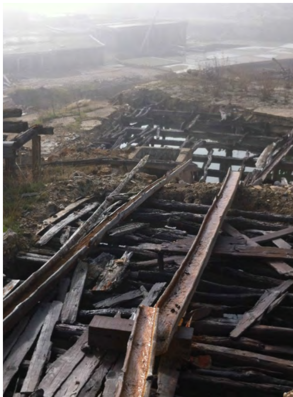
Figura 137. Balsas y canalizaciones sin rehabilitar, en Salinas de Añana (Álava)
