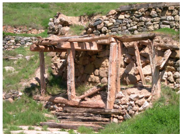
Figura 129. Estado actual de los cristalizadores
