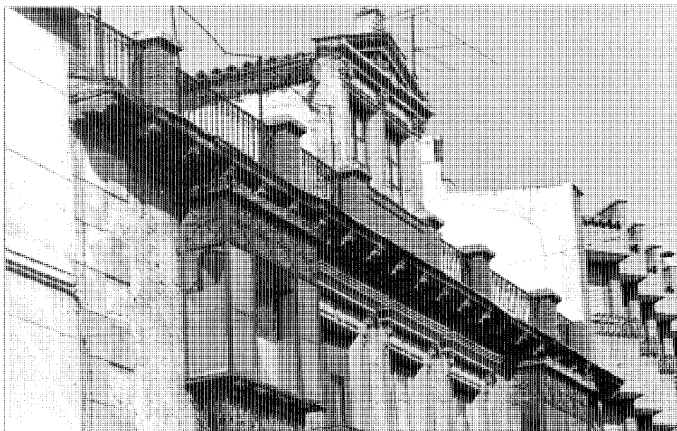
Vivienda. Calle Madrid, 41.
