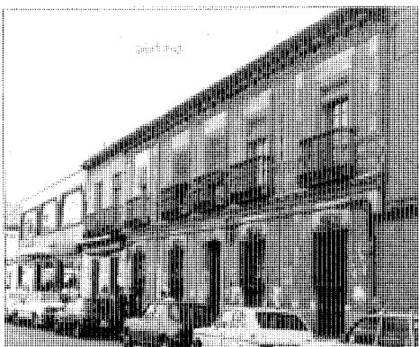
Vivienda. Calle Madrid, 18.
