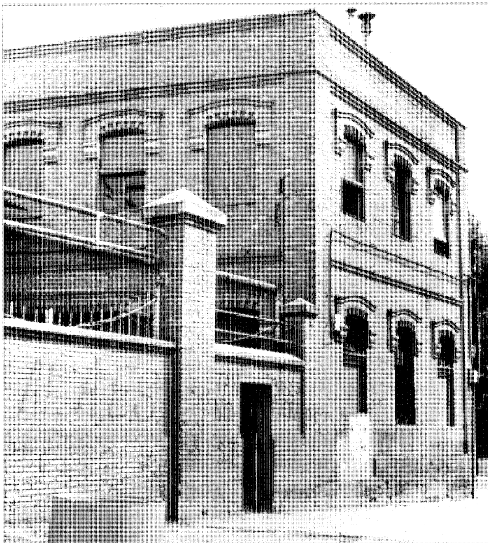
Detalle de la fachada a Ramón y Cajal.
