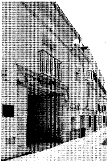
Vivienda en el nº 25 de la calle de la Constitución.
