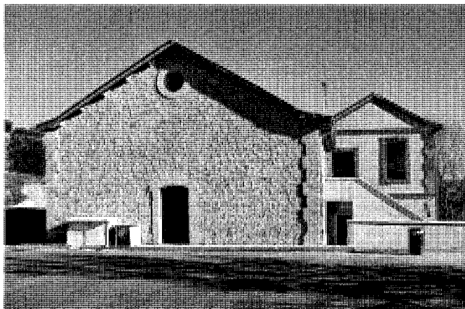
Testero del almacén con la vivienda adosada. Foto Vicente Patón.
