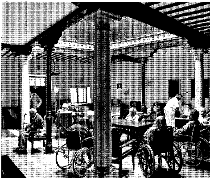
Patio central, con las columnas toscanas de piedra y jónicas de fundición. Foto Vicente Patón.
