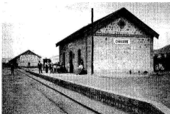
El apeadero de Chávarri en 1910, con el almacén de Aguas de Carabaña al fondo. Foto Lacoste.
