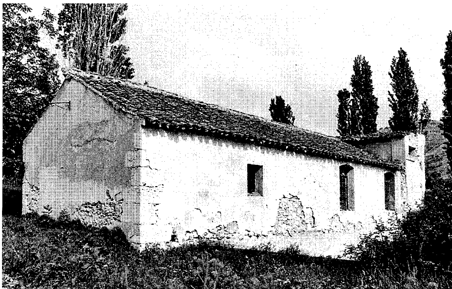
El molino Nuevo hacia 1985, fachada oriental. Foto José Luis García Grinda.
