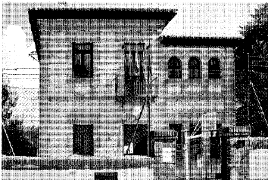
Fachada principal. Foto Vicente Patón.
