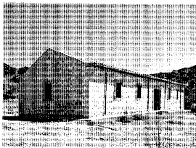
Nave del pozo Central.
