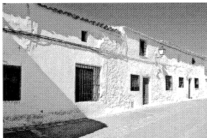
Viviendas en la c/ Paraíso, 5, 7 y 9.
