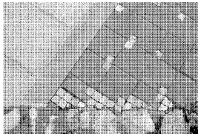
Detalle de la pavimentación de la plaza de la Constitución, 2007. Foto Enrique Krahe.
