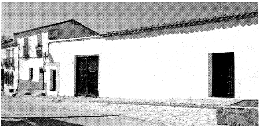
Vivienda en la c/ Nueva, 7.
