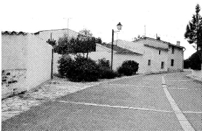
Vivienda (demolida) en la c/ Procesiones, 3 con trasera a Travesía de las Procesiones, 2006. Foto Enrique Krahe.
