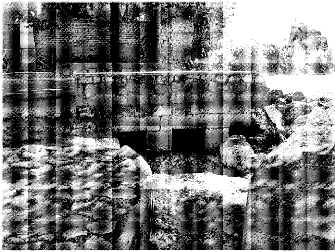
Puente sobre la acequia que bordea la fuente, 2007. Foto Enrique Krahe.
