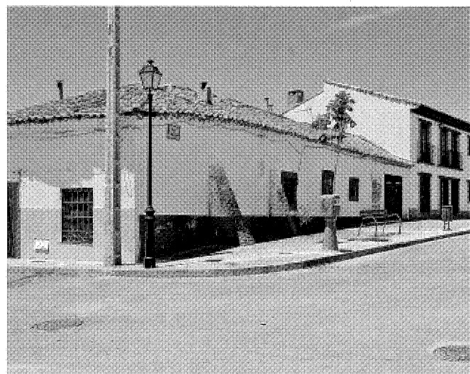
Viviendas rurales con solución de contrafuertes en las calles del Pilar, 11 y del Palacio, 12 c/v plaza del Palacio. Fotos, Félix Cabrero, 2005 y Jose Ablanado, 2007.
