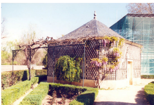
Pabellón del embarcadero
