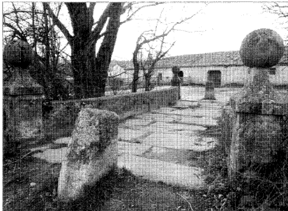
Vista del tablero, al fondo la Casa de la Madera
