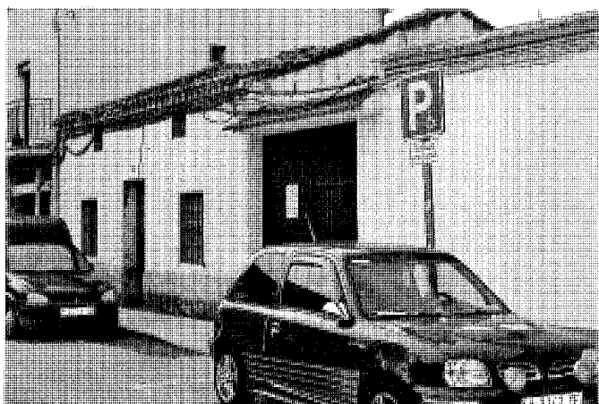
Vivienda rural en la calle Almendralejos, 47. Foto, Félix Cabrero, 2005.
