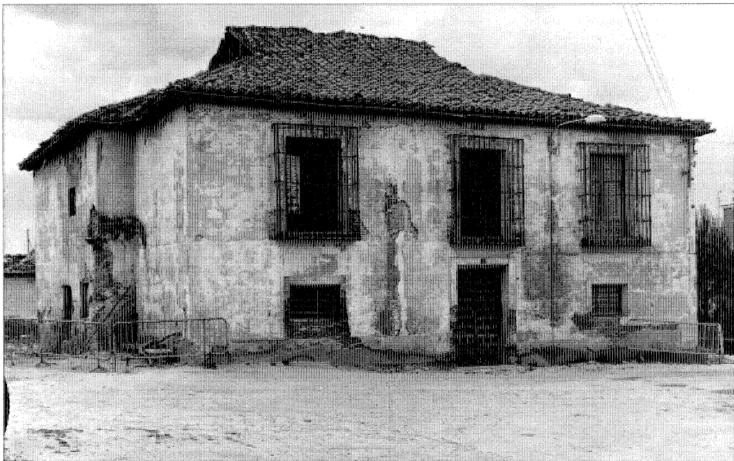
Casona de «La Millonaria» antes de la intervención.
