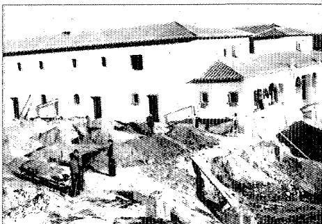
Viviendas en construcción. Años cuarenta. A.G.A. Regiones Devastadas.
