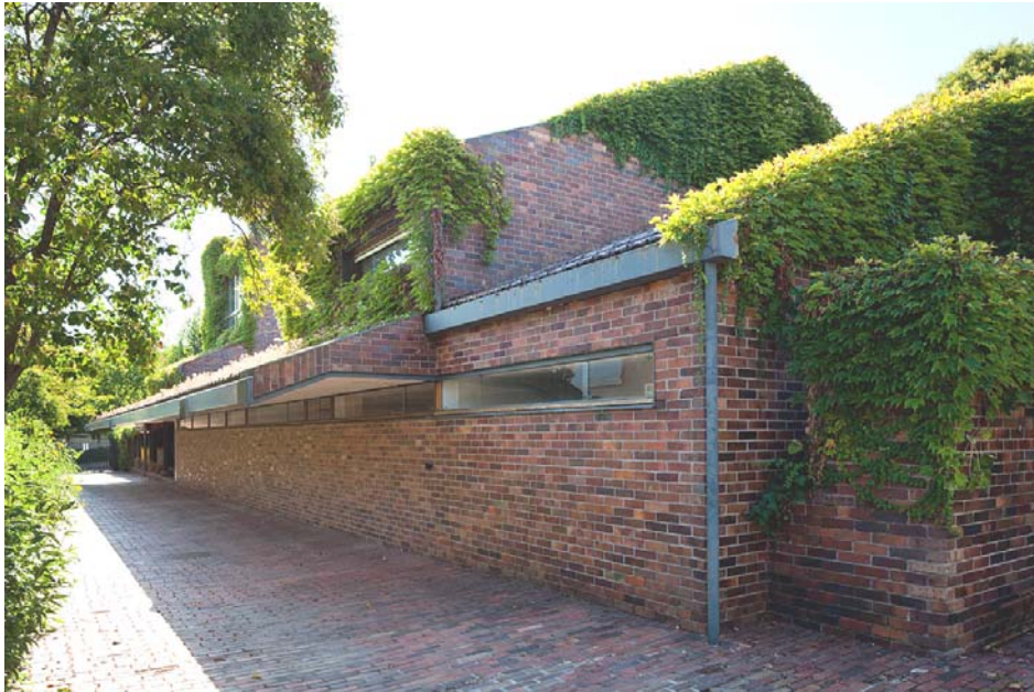
Casa Huarte, ventana corrida del patio de entrada formada por una secuencia de ventanas tipo Pierson que combinan hoja corredera - hoja fija – hoja corredera. Fotografía: Miguel de Guzmán
