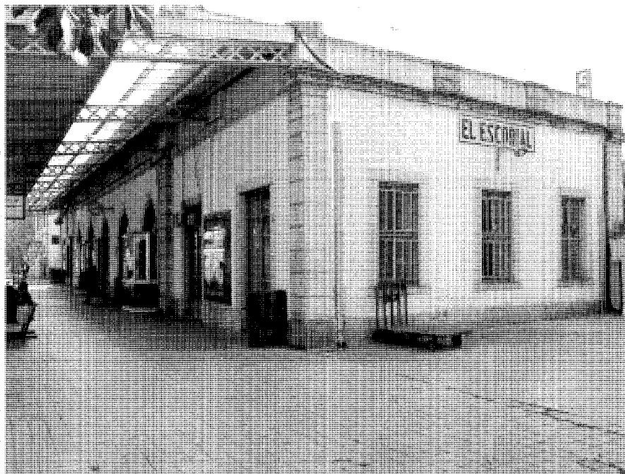
Edificio de viajeros. Fot. José Rodríguez Ablanedo.
