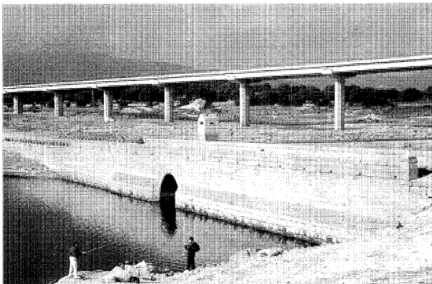
Vista del puente aguas arriba. Hoy se encuentra sumergido bajo las aguas del pantano de Valmayor. Fot. Pilar Martín-Serrano.
