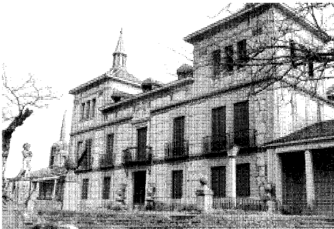
Fachada principal. Fot. Pilar Martín Serrano.
