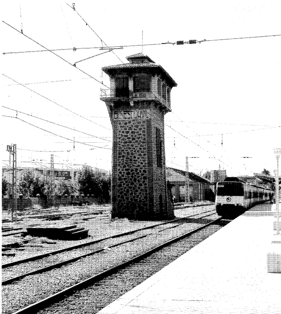
Torre de control de trenes. Fot. José Rodríguez Ablanedo.
