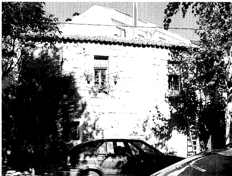
Vista de conjunto. Fot. Pilar Martín-Serrano.
