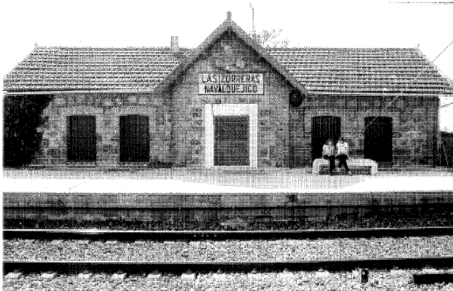
Edificio de viajeros. Fot. José Rodríguez Ablanedo.
