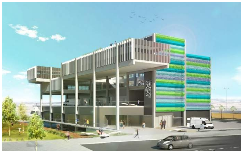
Fig.90: Edificio Sócrates, Viladecans, Barcelona (Fuente: Inmobiliaria GONSI, 2020)
