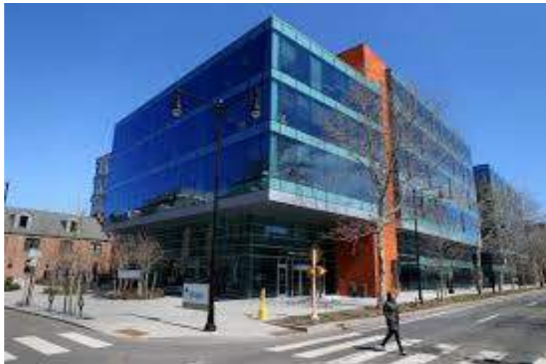
Fig.85: Oficinas Centrales de Biogen Chemicals, Cambridge, Massachusetts, Estados Unidos (Fuente: Biogen, 2013)
