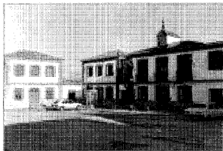
Ayuntamiento y antiguas escuelas, ahora sometidos a intensas obras de remodelación. Inventario de los cascos urbanos de la CAM
