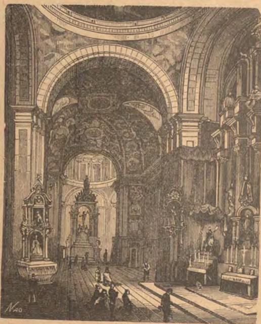
INTERIOR DE LA CAPILLA DE SAN ISIDRO (EN SAN ANDRÉS)
