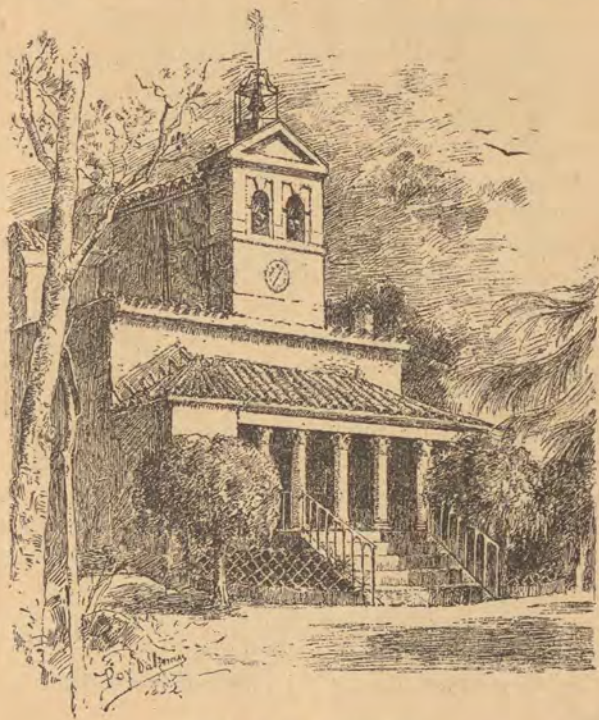
IGLESIA DE LA TORRECILLA
