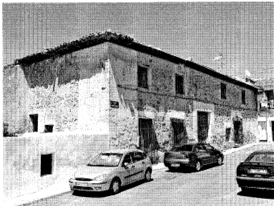
Casona de la Plaza de la Casa Nueva.
