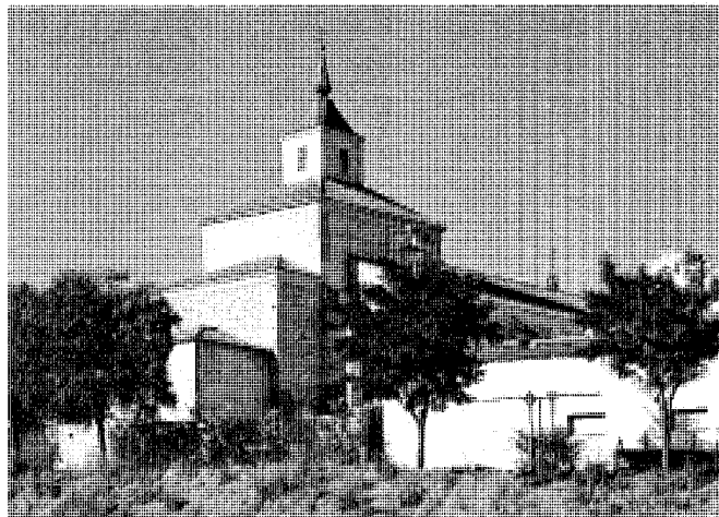
Vista de la cabecera y fachada norte.
