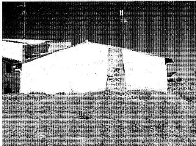
Chimenea sobre terreno. Foto Inmaculada Sánchez.
