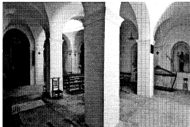
Interior. Nave lateral izquierda.
