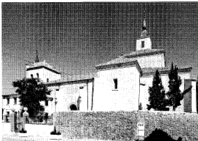
Vista fachada sur.
