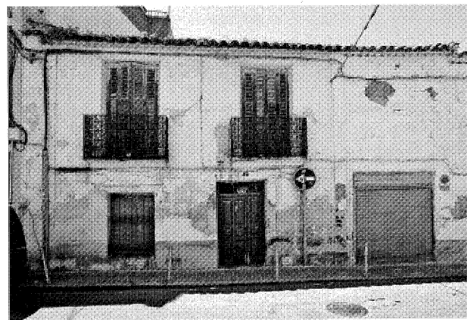
Vivienda en la calle Mayor, 4.
