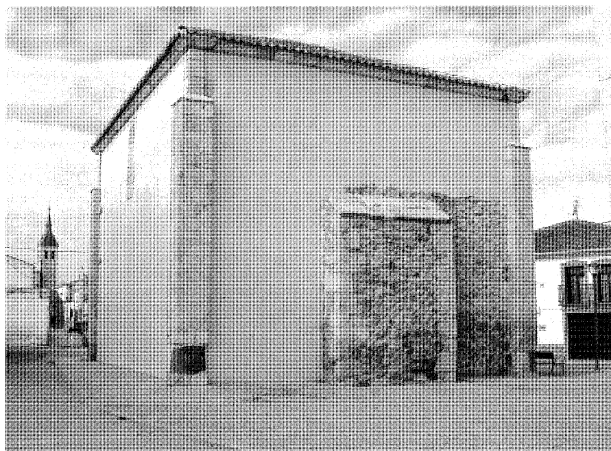
Vista de la fachada trasera.
