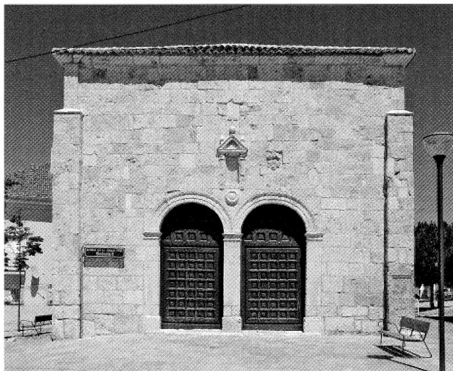
Vista de la fachada de acceso.
