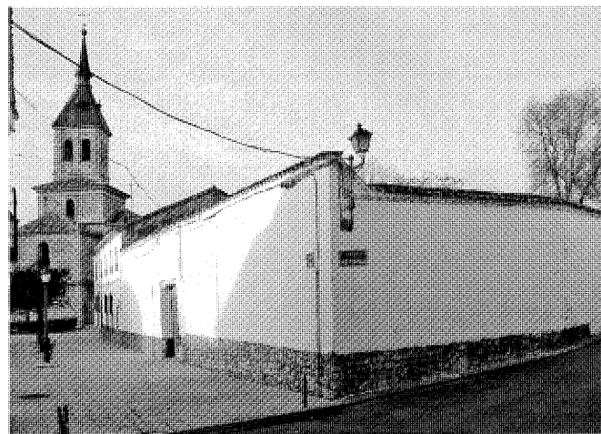
Esquina de la plaza del Sol con el callejón de las Cuadras. Foto Ángel Cordero.
