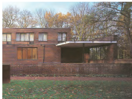
FIGURA IV.1-50 Columna de acero sosteniendo la losa volada que da al jardín. Dibujo del autor.
