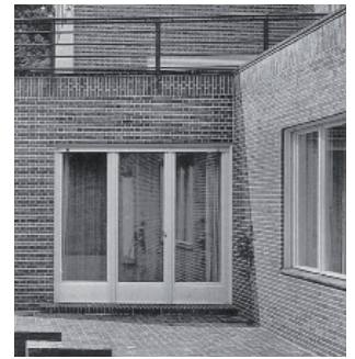
FIGURA IV.1-40 Casa Wolf. Ladrillo pasando por encima de la ventana con subestructura de dintel oculta.
