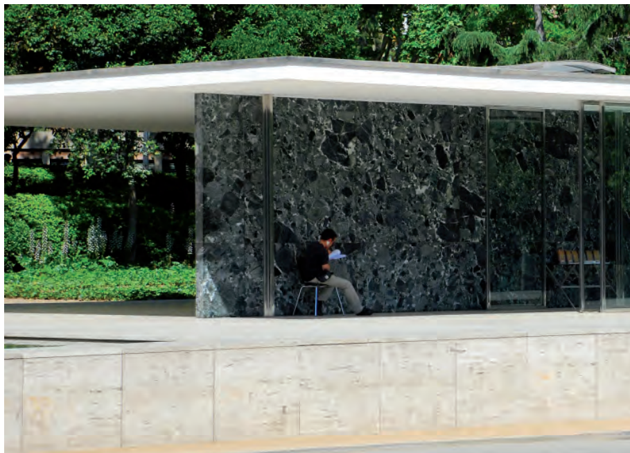
FIGURA IV.3-05 Pabellón de Barcelona. Discontinuidad techo-columna-podio por un cambio de materiales. Fotografía del autor.
