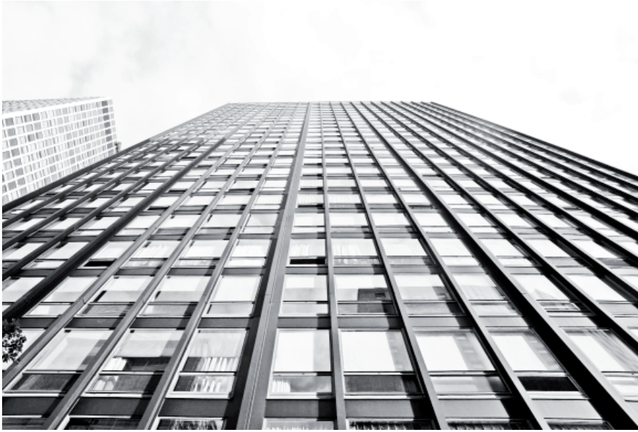
FIGURA IV.2-127 LSD Apartments. Detalle de fachada. Fotografía del autor.
