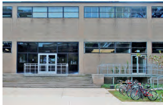
FIGURA IV.2-26, izquierda Engineering Research Building, IIT, Chicago, 1944-1946. Fuente: internet.
