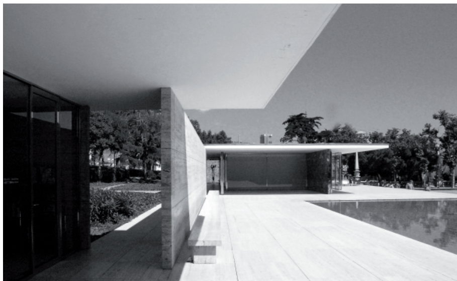
FIGURA IV.3-08 Pabellón de Barcelona. Ruptura de la caja. Desplazamiento de elementos horizontales respecto a los elementos verticales. Fotografía del autor.
