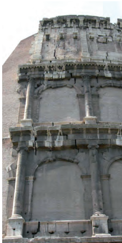
FIGURAS III.2-28 y III.2-29 Interior del Coliseo y detalle de los tres pisos superiores de la fachada. El contraste entre los potentes contrafuertes y la esbeltez de las columnas. Fotografías del autor.
