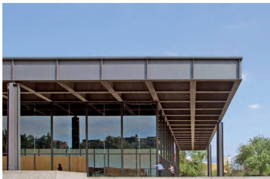
FIGURA IV.3-69 Galería Nacional de Berlín. La viga de esquina permanece con canto constante. Fotografía del autor.
