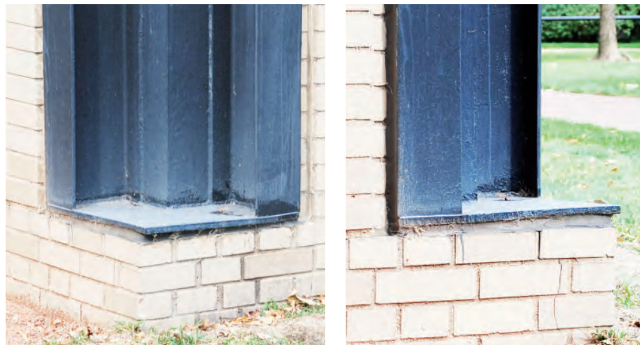
FIGURA IV.2-106 y IV.2-107 Detalle del pilar de esquina del Alumni Memorial Hall. En el vértice, la chapa de acero negro cubriendo el pilar de hormigón interior. A ambos lados, el perfil de la subestructura sin función estructural. Fotografía del autor.
