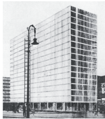
FIGURAS IV.2-87 Y 88 Remodelación de la Alexanderplatz, Berlín, 1928. Conjunto de bloques prismáticos de vidrio y acero de diecisiete a diez plantas. La estructura está formada por una retícula ortogonal de pilares y forjados de acero. A la derecha, la torre principal de oficinas, con el cerramiento de vidrio por delante de las columnas. Fuente: DREXLER, Arthur. Ludwig Mies van der Rohe . George Braziller, Inc, Nueva York, 1960
