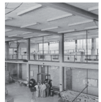
FIGURA IV.2-ii Interior del espacio en doble altura del Alumni Memorial Hall con las vigas de canto unidireccionales a la vista. Fuente: IIT Chicago
