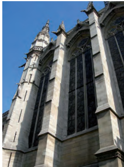
FIGURA III.1-33 Arriba izquierda Imagen de los contrafuertes exteriores. Fotografía el autor
