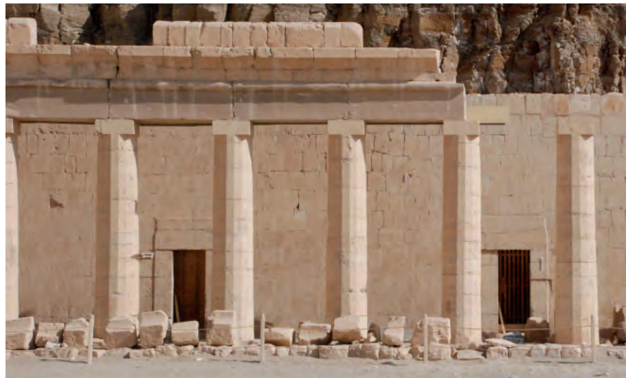
FIGURA 4 Templo de Hatshepsut. Pórtico lateral. Fotografía del autor.
