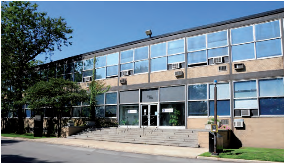
FIGURA IV.2-114 Colegio de Música del IIT. Subestructura de acero y plementería de ladrillo macizo ocultando la estructura. Fuente: internet
