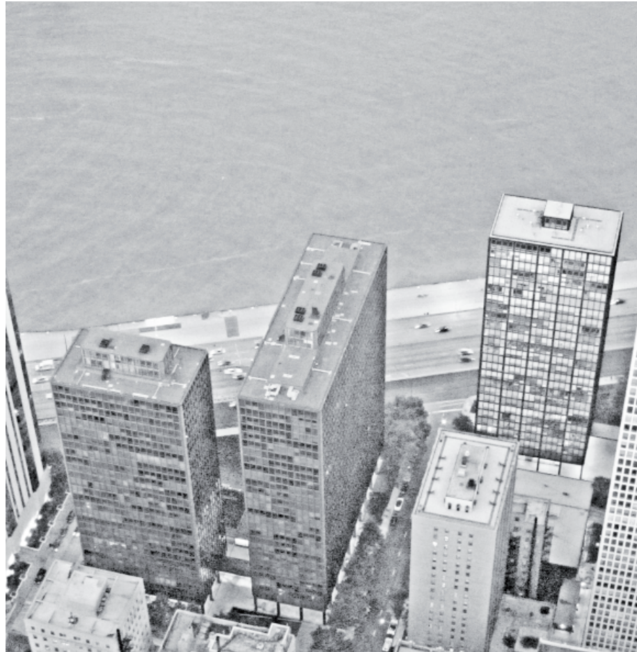
FIGURA IV.2-136 Apartamentos en 900 Esplanade, Chicago, 1953-1956. Dos torres de 29 plantas, con estructura reticular cuadrada de crujía tipo 21'x21', 6.5 x 6.5 metros. Una de las torres tiene 5x3 módulos, la otra 10x3 módulos. Por temas de presupuesto la parte baja de las torres se soporta con estructura de acero, y la superior con hormi- gón armado, más barato. Fotografía del autor.
