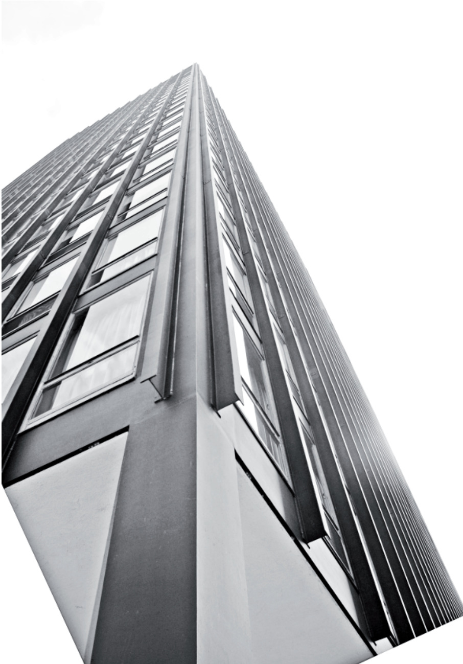
FIGURA IV.2-128 LSD Apartments. Detalle de fachada. Fotografía del autor.
