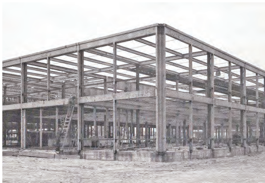
FIGURA IV.2-111 Perlstein Hall en construcción. Estructura unidireccional, columnas, y subestructura por delante de las columnas y partiendo en dos el vano estructural. Fuente: MERTINS, Detlef. Mies . Phaidon Press, Londres, 2014
