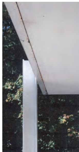
FIGURA IV.1-101, izquierda La columna por delante de la viga. La sombra ayuda a separar visualmente los dos elementos. Fotografía del autor.
