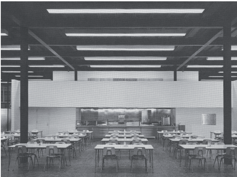
FIGURA IV.2-35 Interior del Commons Building con la estructura a la vista. Coincidencia de plano de las alas inferiores de vigas y correas, que anula visualmente la diferencia de canto de los perfiles. Fuente: CARTER, Peter. Mies van der Rohe trabajando . Phaidon Press Lt, Londres, 2006. Traducción: Gemma Deza Guil. Primera edición, 1974.
