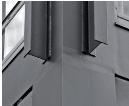
FIGURA IV.2-124, derecha Detalle de pilar de esquina. Fotografía del autor.
