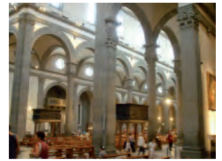
FIGURA III.1-39 Iglesia de San Lorenzo, Florencia, con los elementos principales de la estructura en pietra serena gris.
