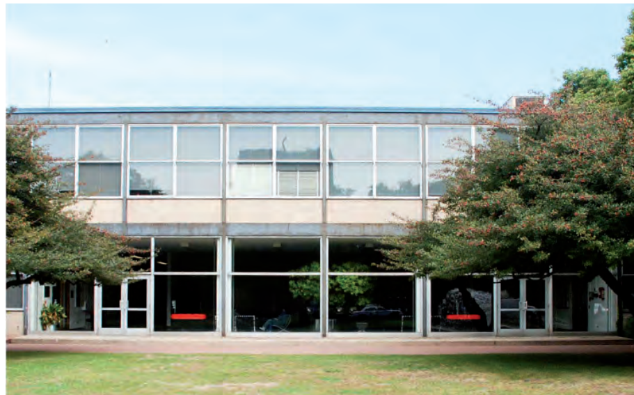
FIGURA IV.2-110 Perlstein Hall. Imagen exterior que muestra la perfilera de la subestructura por delante de las columnas. Fotografía del autor.
