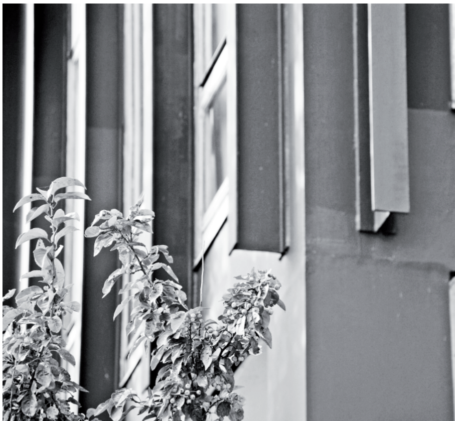
FIGURA IV.2-125 Detalle de fachada. La sub- estructura en relieve respecto al plano de fachada. Fotografía del autor.
