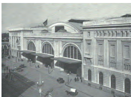
FIGURA III.2-63 Estación de Francia; arquitectos, Pedro Muguruza y Raimon Duran i Reynals; Barcelona, 1929. Fuente: Izquierda, fotografía del autor. Derecha, Internet
