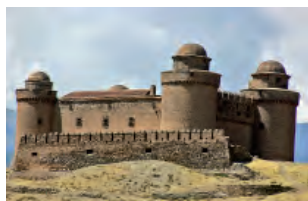
FIGURA III.1-23 Materialidad de una construcción defensiva. Castillo de la Calahorra, Granada.
