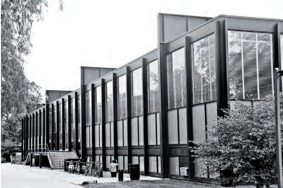
FIGURA IV.3-38 Crown Hall. Vista exterior con la presencia destacada del esqueleto estructural. Fotografía del autor.
