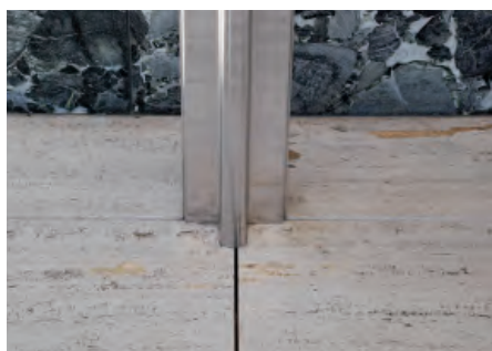
FIGURA IV.3-07, derecha Pabellón de Barcelona. Falta de concordancia entre la modulación de la estructura y la modulación del pavimento. Fotografía del autor.
