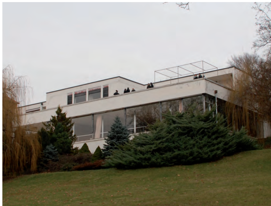
FIGURA IV.1-70. Fotografía actual de la casa Tugendhat que sigue mostrando la zona de apoyo techo-columna en sombra. Fotografía del autor.
