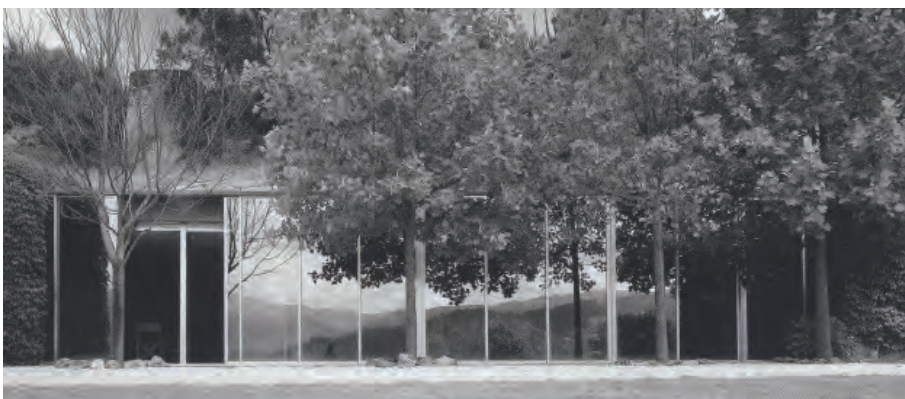
FIGURA IV.1-110 Casa en Baiao, 1992, arq. Eduardo Souto de Moura. El trabajo de Souto continúa con la claridad tectónica de Mies, en combinación con la sensibilidad y el uso de materiales y técnicas del lugar. Fuente: Giovanni Leoni. Eduardo Souto de Moura. Ed. Gustavo Gili, Barcelona, 2004.
