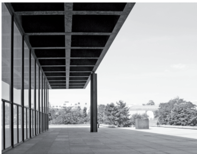
FIGURA IV.3-65 Galería Nacional de Berlín. Es- quina en voladizo y con el cerra- miento de vidrio retranqueado. Fotografía del autor.
