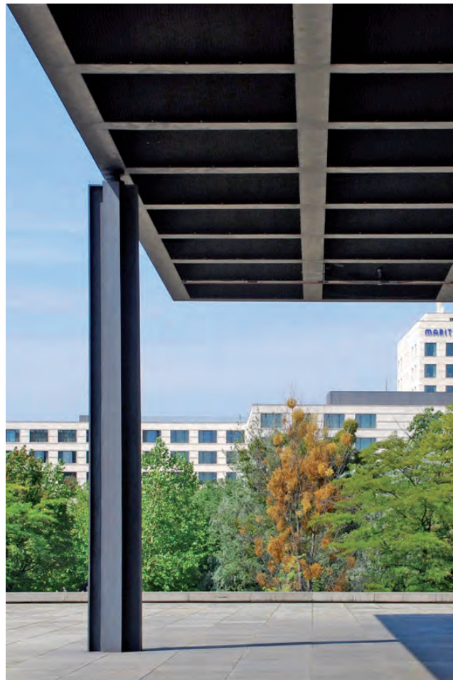
FIGURA IV.3-77 Galería Nacional de Berlín. Detalle de apoyotecho-columna. Fotografía del autor.
