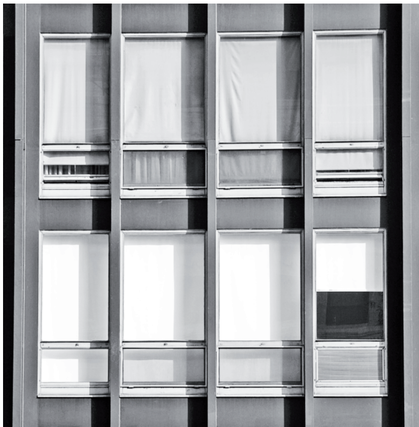
FIGURA IV.2-130 LSD Apartments. Detalle de fachada. Fotografía del autor.
