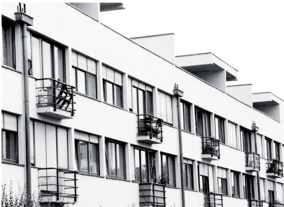
FIGURA IV.2-24 Columnas de acero vibrando en la fachada. Bloque de viviendas, Weissenhofsiedlung. Fotografía del autor.
