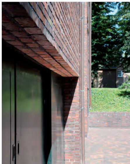
FIGURA IV.1-55 Dintel de ladrillo ocultando la subestructura de acero en el hueco de garage de la Casa Lange. Fotografías del autor.
