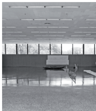
FIGURA IV.3-40 Crown Hall. Vista interior con el techo en suspensión. En el interior del gran espacio no hay resto de las vigas monumentales. Y las columnas no intersecan con el techo. No hay alusión al apoyo. Fotografía del autor.
