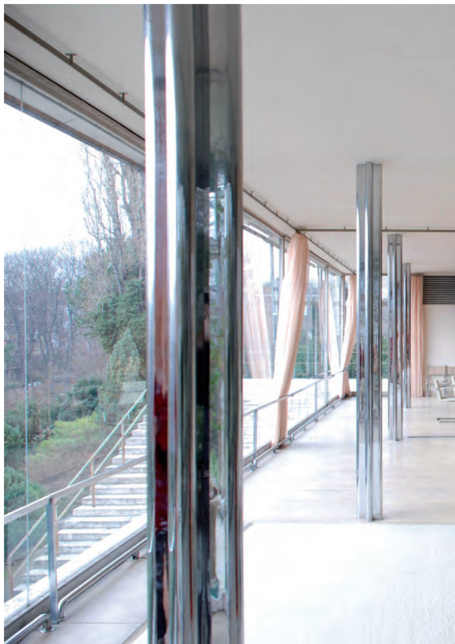
FIGURA IV.1-65. Columna cruciforme revestida con camisa reflectante de acero cromado. Fotografías del autor.
