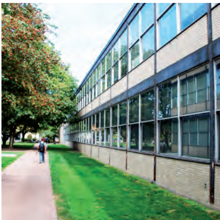
FIGURA IV.2-103 y IV.2-104 Alumni Memorial Hall. Pilares de la subestructura que no llegan al suelo. Fotografía y dibujo del autor.
