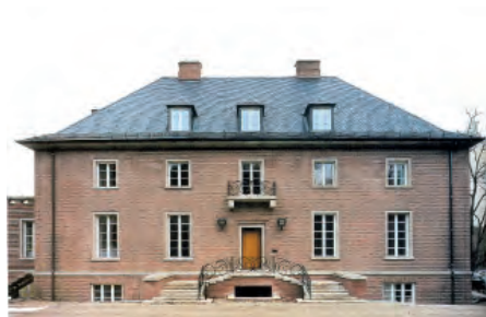
FIGURA IV.1-37 Tres muros de ladrillo. Izquierda, casa Mosler. Derecha arriba, Casa de campo de ladrillo. Debajo, Monumento KL-RL
