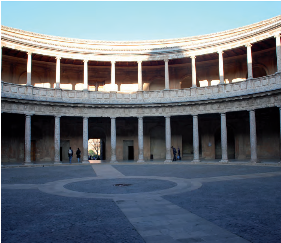
FIGURA III.2-46 Las relaciones proporcionales nos demuestran una mayor densidad de columnas en planta baja. Las columnas del nivel superior son más esbeltas, y parecen más distanciadas entre sí. Las columnas del nivel inferior son más robustas, y parecen más próximas entre sí, debido a la mayor verticalidad del intercolumnio. Fotografía del autor.
