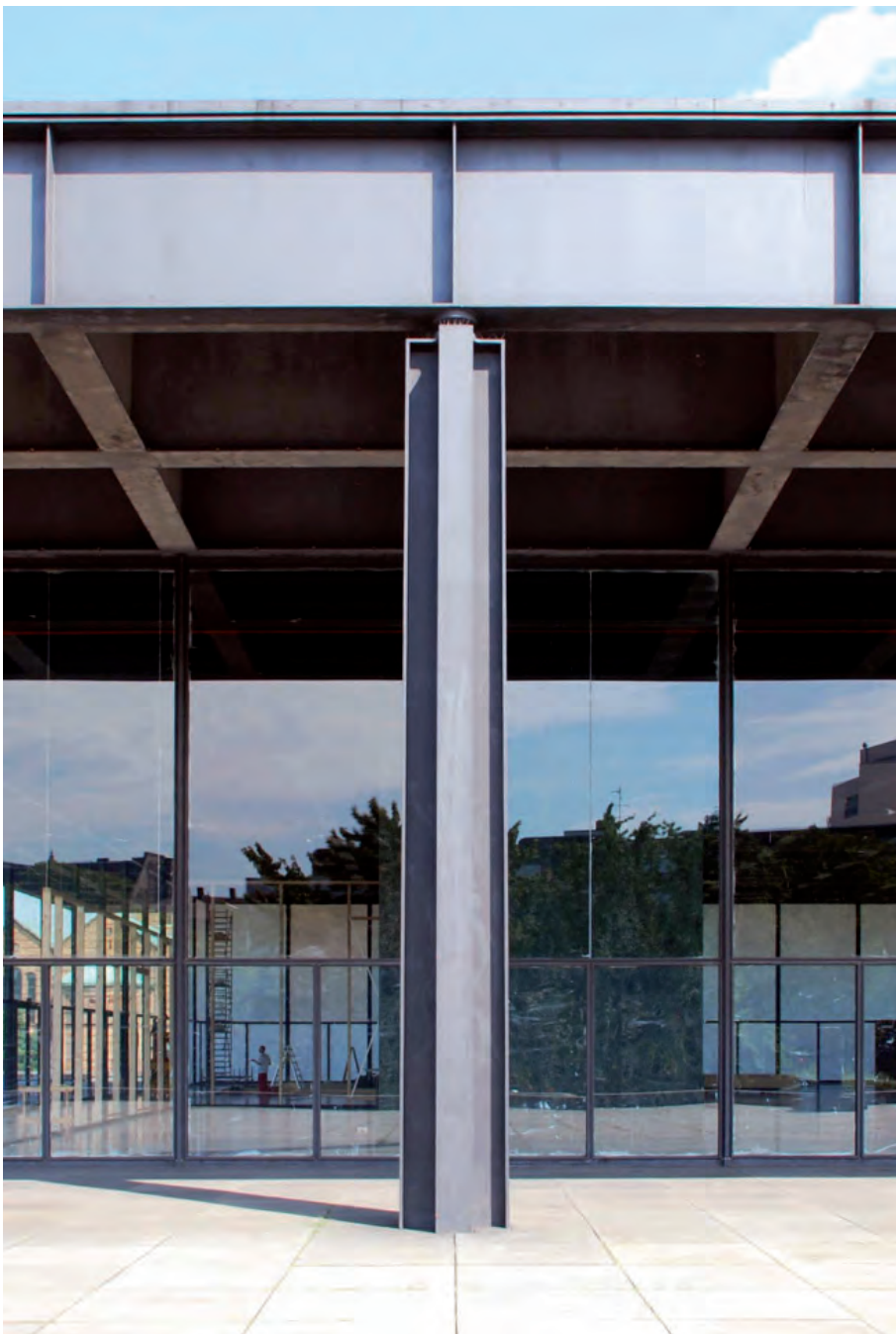
FIGURA IV.3-74 Galería Nacional de Berlín. Encuentro techo-columna en sombra, en discontinuidad. Fotografía del autor.
