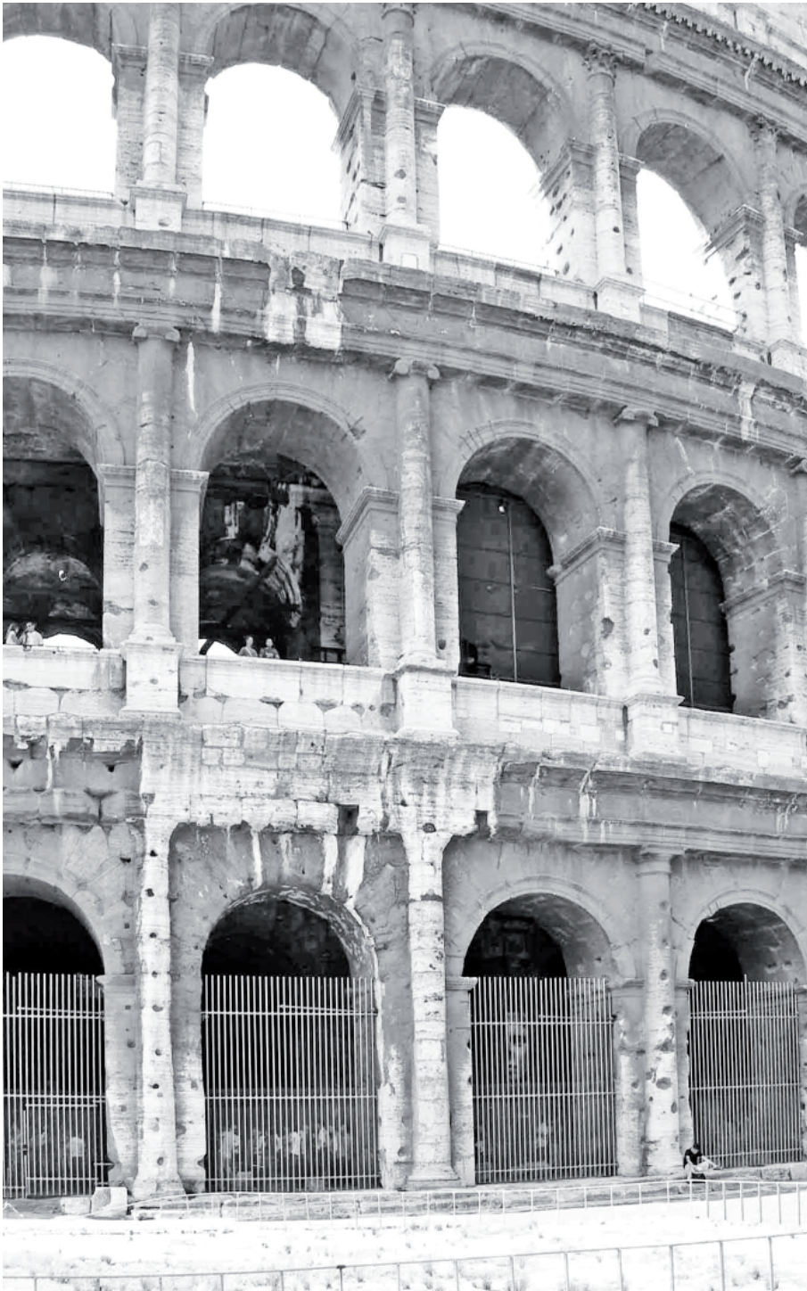
FIGURA IV.2-160 Coliseo de Roma, 72-80 d.C. Orden decorativo de columnas por delante de la estructura muraria. Fotografía del autor.
