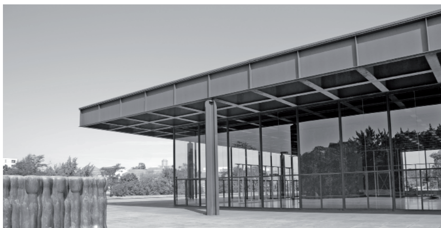
FIGURA IV.3-64 Galería Nacional de Berlín. Esquina en voladizo y con el cerramiento de vidrio retranqueado. Fotografía del autor.
