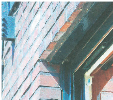
FIGURA IV.1-53, izquierda Presencia del dintel de acero en una ventana de la Casa Esters. Fotografía del autor.
