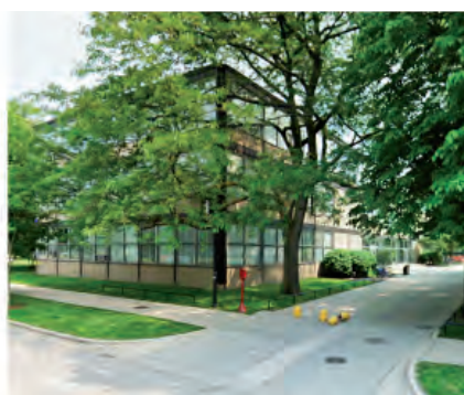
FIGURA IV.2-115 Siegel Hall. Sus dimensiones, sistema de cerramiento y estructura son similares a los del Whisnick Hall. Fuente: internet
