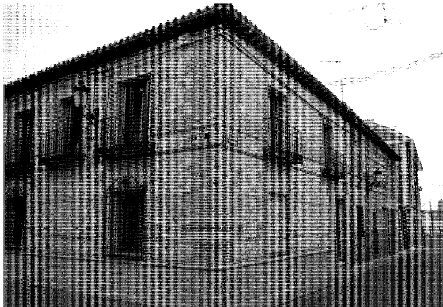
Vivienda del siglo XVIII en Pza. de la Constitución, c/v a C/ Escalinata de la Iglesia, 6 y 7, conocida como "casa Escobar". Foto José Ablanedo.
