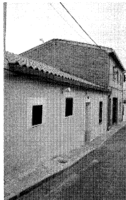
Vivienda en Travesía de la Iglesia, 4. Foto: José Ablanedo.
