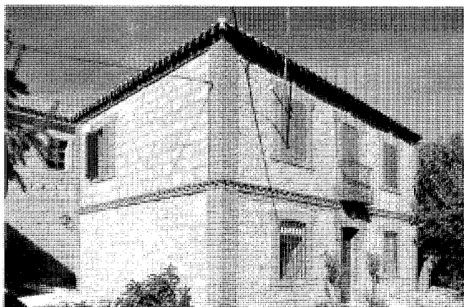
Casa del cura. Fot: Actividades y Servicios Fotográficos S.A.
