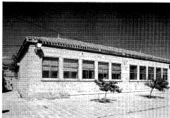
Escuelas. Fot: Actividades y Servicios Fotográficos S.A.
