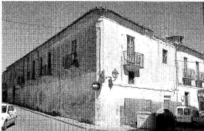
Vivienda en calle Nicasio Fraile c/v Alarcón.
