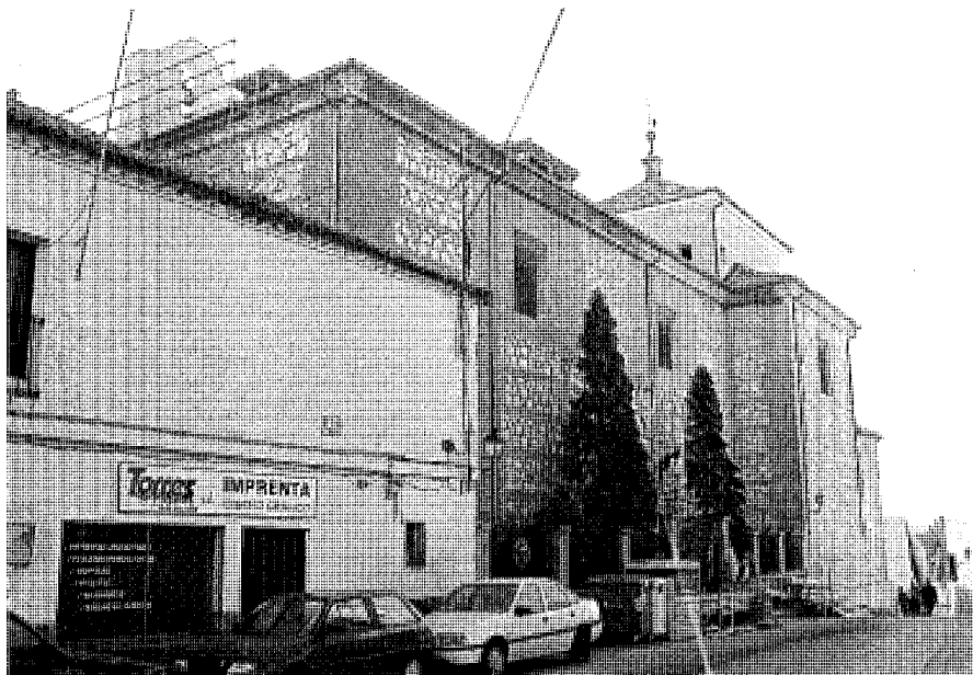
Vista de la fachada principal.
