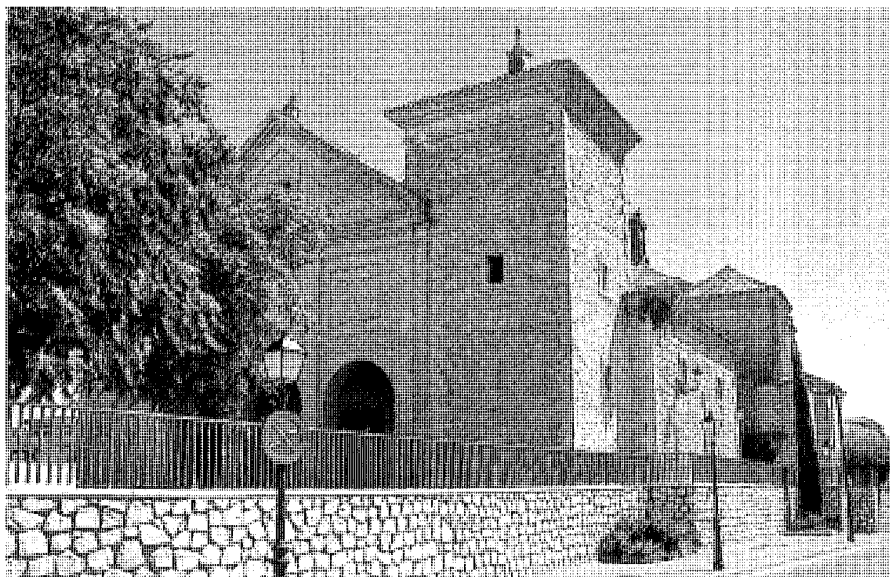
Vista de la fachada principal.
