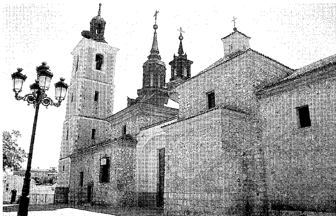
Vista de la fachada septentrional.
