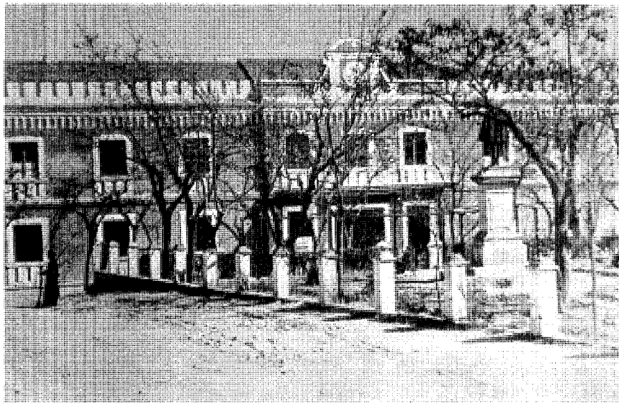
Antigua vista de la fachada principal del Colegio de Guardias Jóvenes. Memoria de Valdemoro I. Fotografías.
