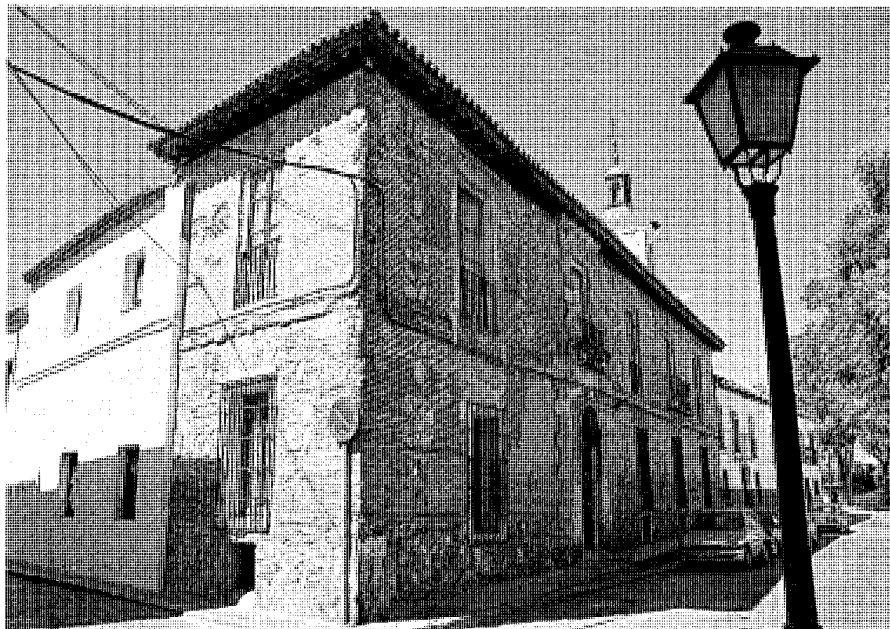
Vista de la fachada principal.
