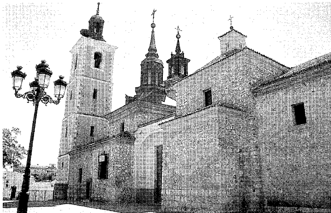
Vista de la fachada septentrional.
