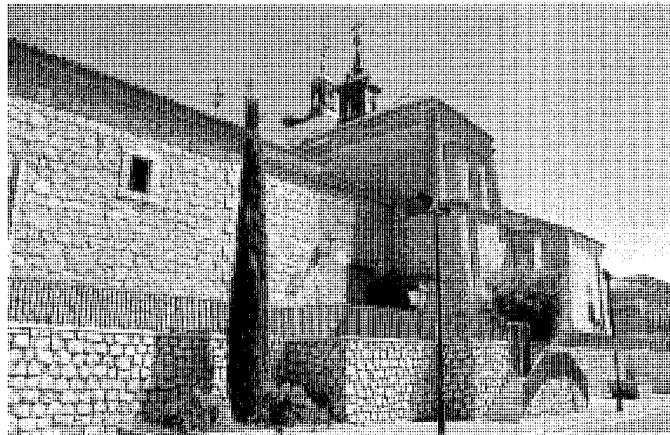
Vista de la fachada meridional.
