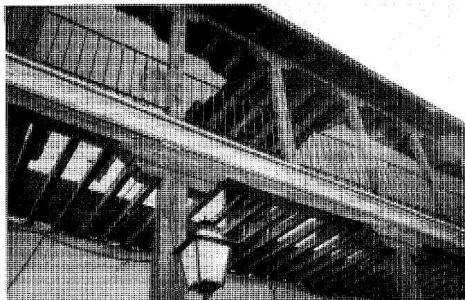
Vista sistema constructivo de los corredores del edificio de la Torre del Reloj y antiguo pósito. Foto Alberto Sanz.
