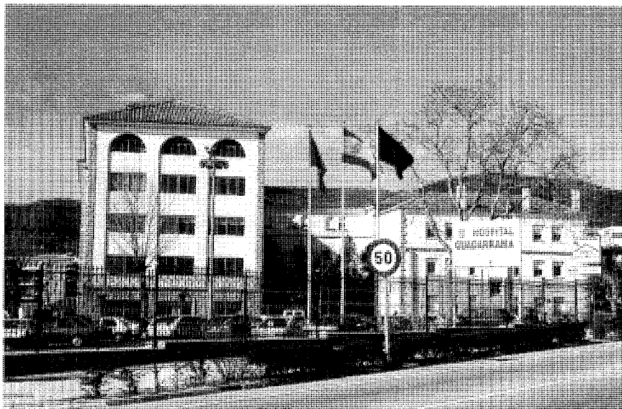
Hospital Guadarrama. Estado actual. Fot. Cristina García.
