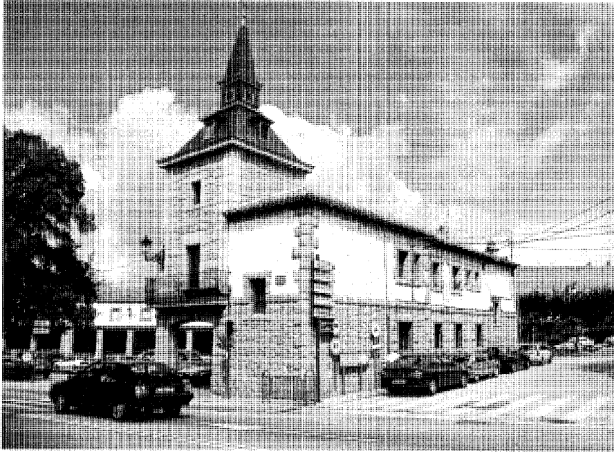
Vista de la fachada posterior. Fot. José Rodríguez Ablanado / Cristina García.
