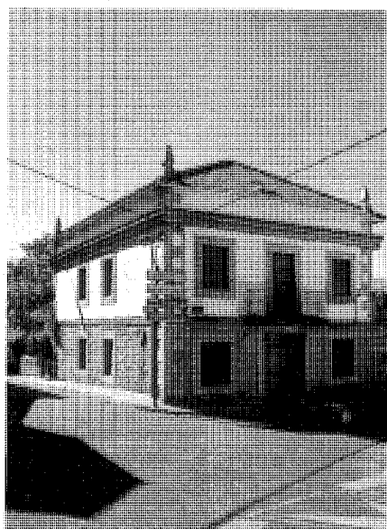
Casón unifamiliar rehabilitado en la calle Reyes Católicos c/v San Francisco de Asís. Fot. José Rodríguez Ablanedo .
