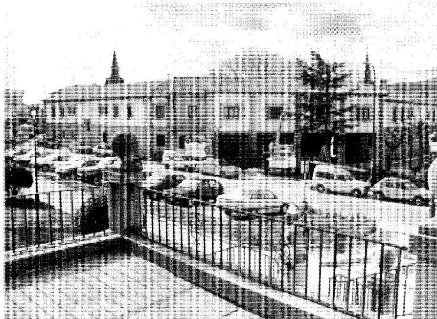
Vista de la fachada posterior. Fot. José Rodríguez Ablanedo / Cristina García.
