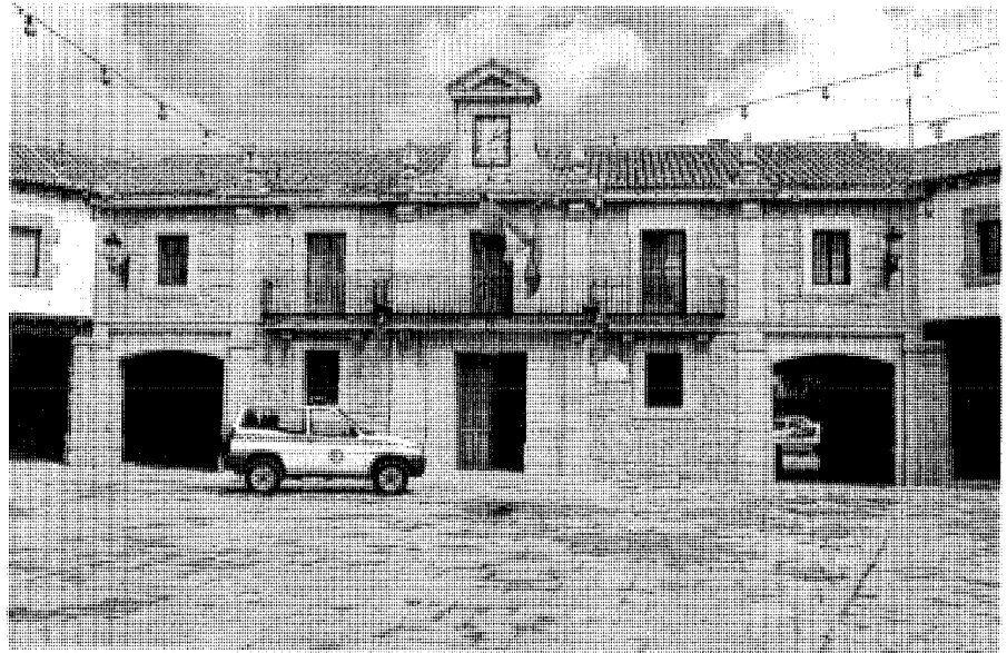
Estado actual de la Casa-Ayuntamiento. Fot. José Rodríguez Ablanedo.
