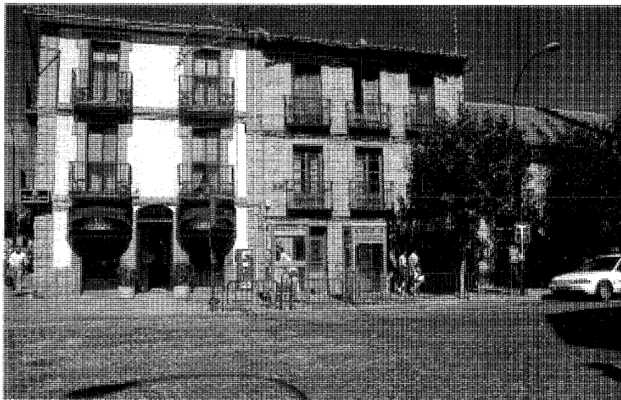
Viviendas de la calle José Antonio Primo de Rivera, 1, 3 y 5. Fot. José Rodríguez Ablanedo.
