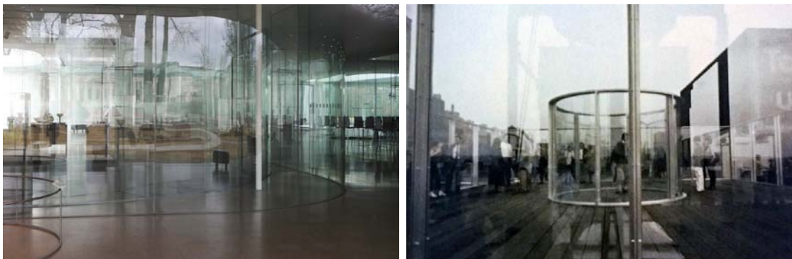
Fig. 1.3. Pabellón de Vidrio, Toledo, Ohio. SANAA, (2001-2006)
