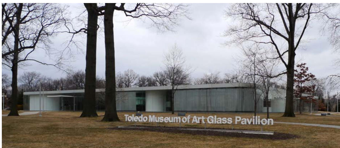
Fig.7.46. Vista desde el Museo. Visita a obra 21-03-2013.
