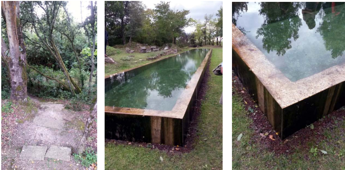
Figs.7.34, 7.35, 7.36. Camino de acceso, lámina de agua, borde desbordante. Visita obra 19-09-2015.
