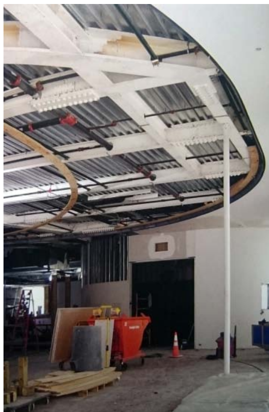
Fig.7.52. Vista interior en construcción. Articulación soporte-cubierta.
