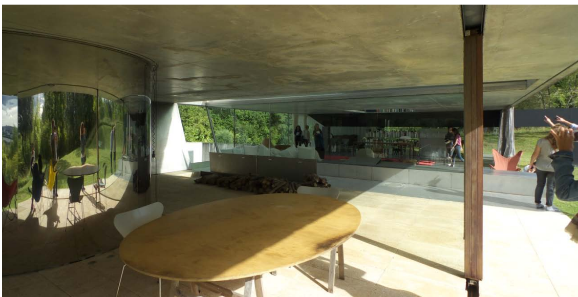
Fig.7.23. Vista desde el exterior cubierto. En primer plano marco de carpintería corredera, cilindro de escalera en acero inoxidable y, al fondo, viga en negro con soporte interior –el extremo exterior sale de la imagen. Visita a la obra 19/09/2015
