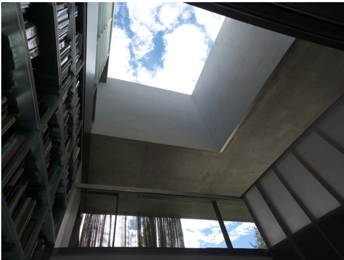
Fig.7.28. Espacio de la plataforma móvil desde planta cueva. Las protecciones del resto de plantas están activadas. Visita a la obra 19/09/2015.
