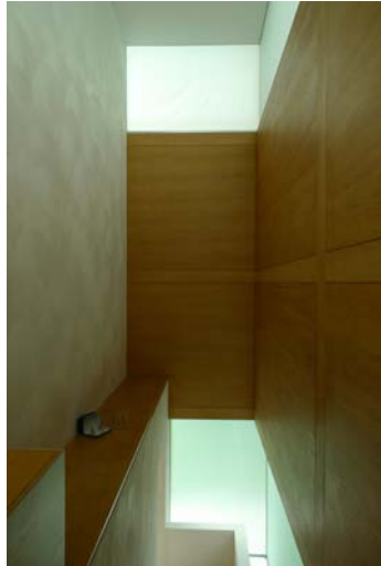
Fig. 4.22. caja escalera interior
