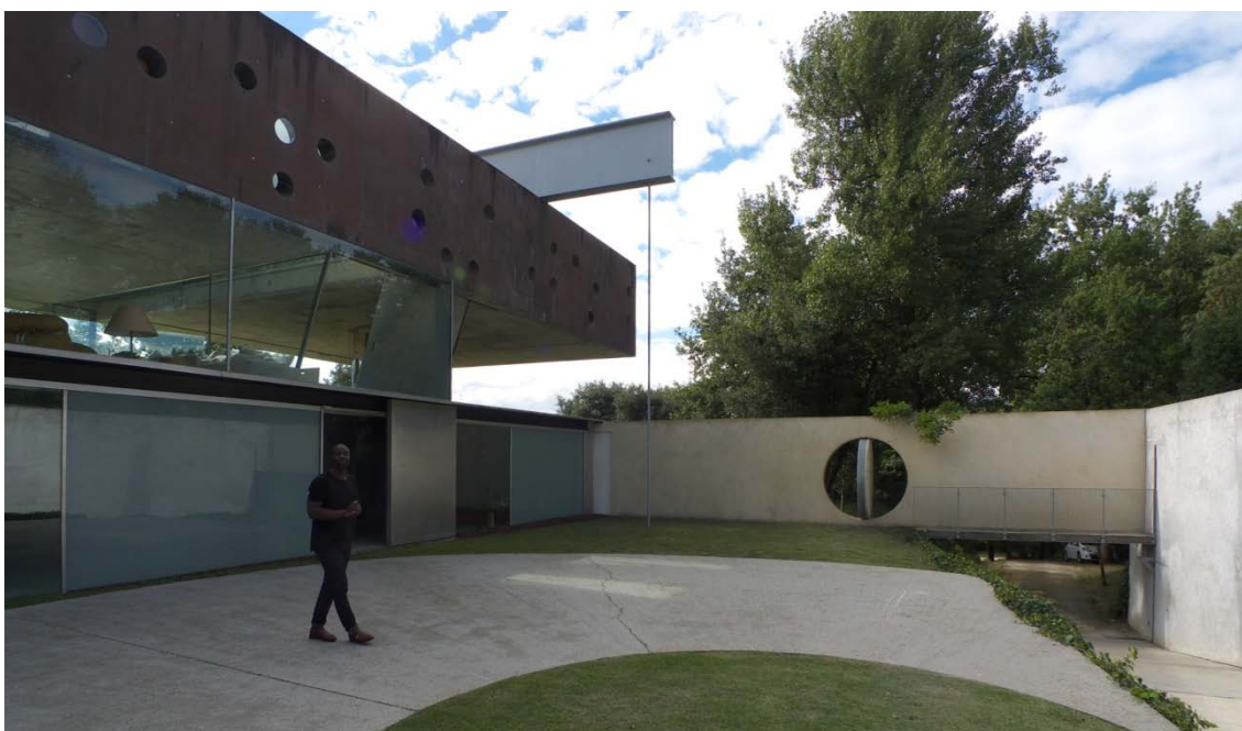
Fig.7.26. Vista del patio de acceso. Visita a la obra 19/09/2015
