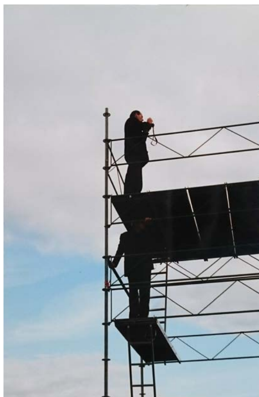
Fig.7.19. Rem Koolhaas y Cecil Balmond sobre andamio montado a cota de casa en sus primeras visitas al terreno.
